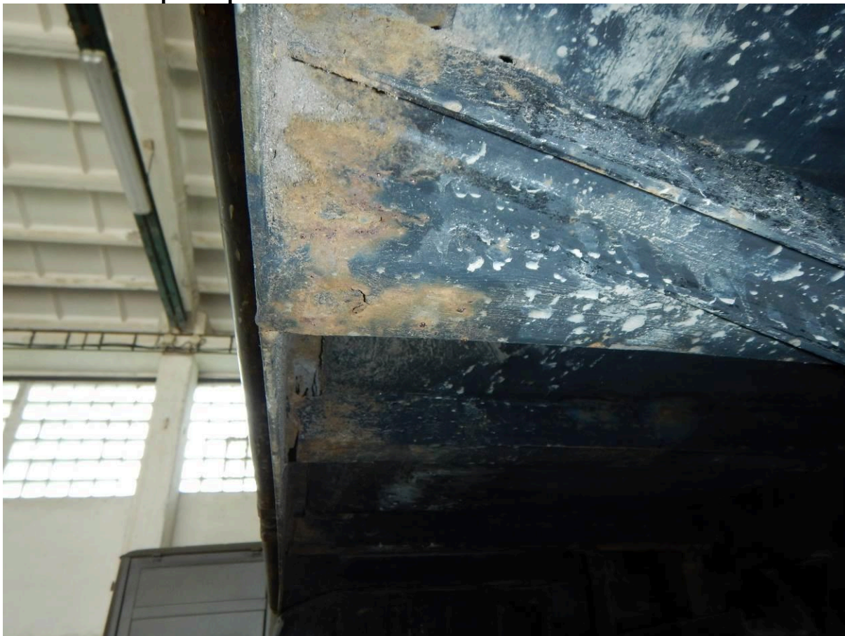
Foto č. 8 koroze příček podběhů zadních kol
