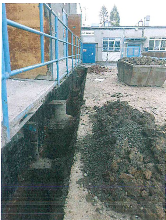
původní výkopek určený ke zpětnému zásypu
