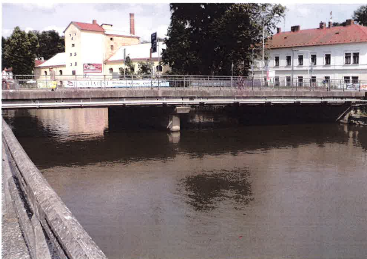
pohled proti proudu řeky Tiché Orlice na rekonstruovaný most 317-005A
