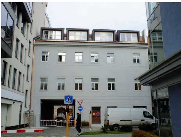
Část jižní fasády (7. 12. 2015)
