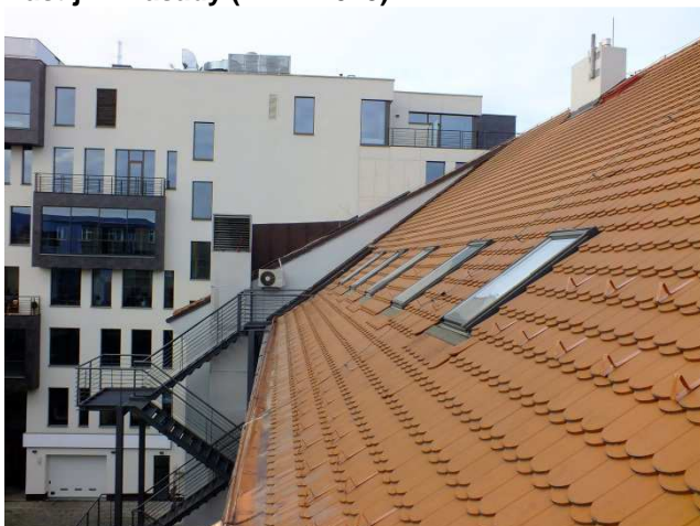
Pohled na střechu objektu (7. 12. 2015)
