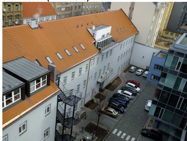
Pohled ze střechy protějšního objektu (7. 12. 2015)
