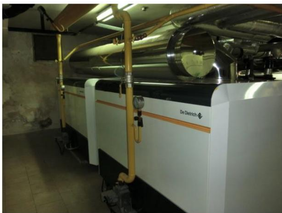
Obrázek 33 – Kotle DTG 330-20
