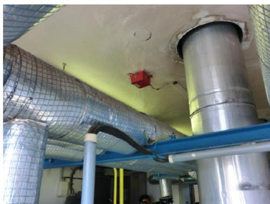
Obrázek 7 - Odkouření kotle
