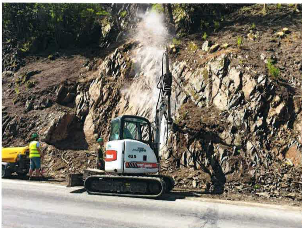
foto 4, SO 105, vrtání TOP a clon, květen 2018
