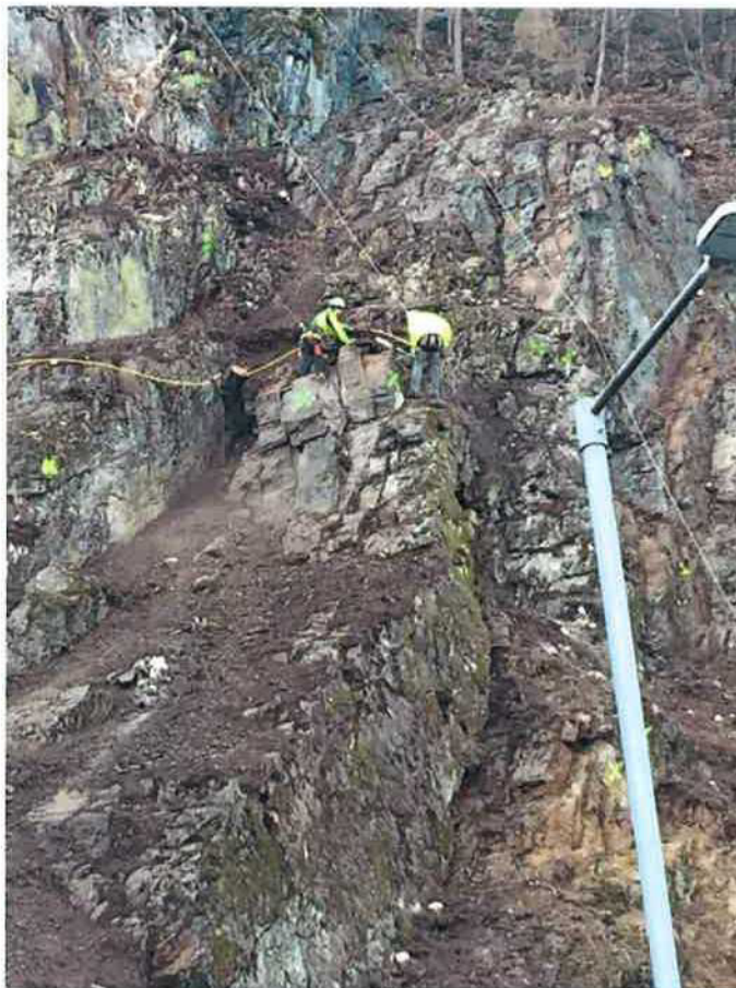
foto 4, SO 107, montáž dynamické bariéry, červen 2018
