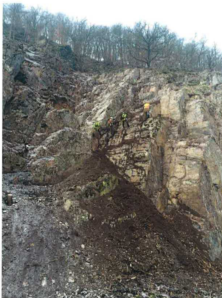
foto 2, SO 107, čištění skalní stěny, říjen / listopad 2017
