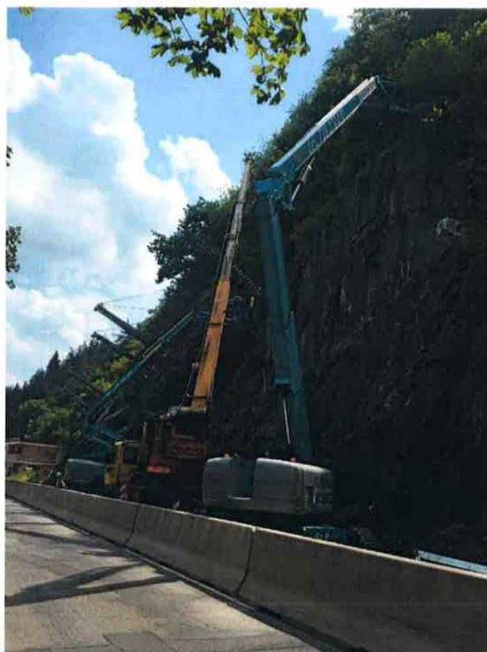
foto 4, SO 107, montáž dynamické bariéry, červen 2018
