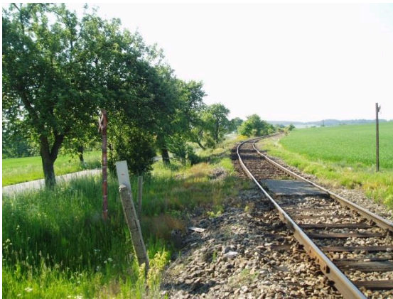
Přejezd P1378 v km 37,355:
