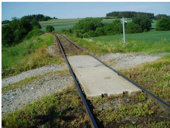
Přejezd P1378 v km 37,355:
