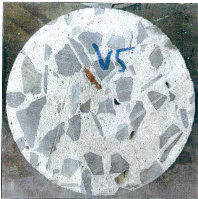
Foto 11: Pohled na líc vývrtnu V5 před zkouškou
