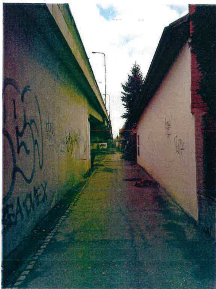
Stávající stav opěrné zdi SO 202
