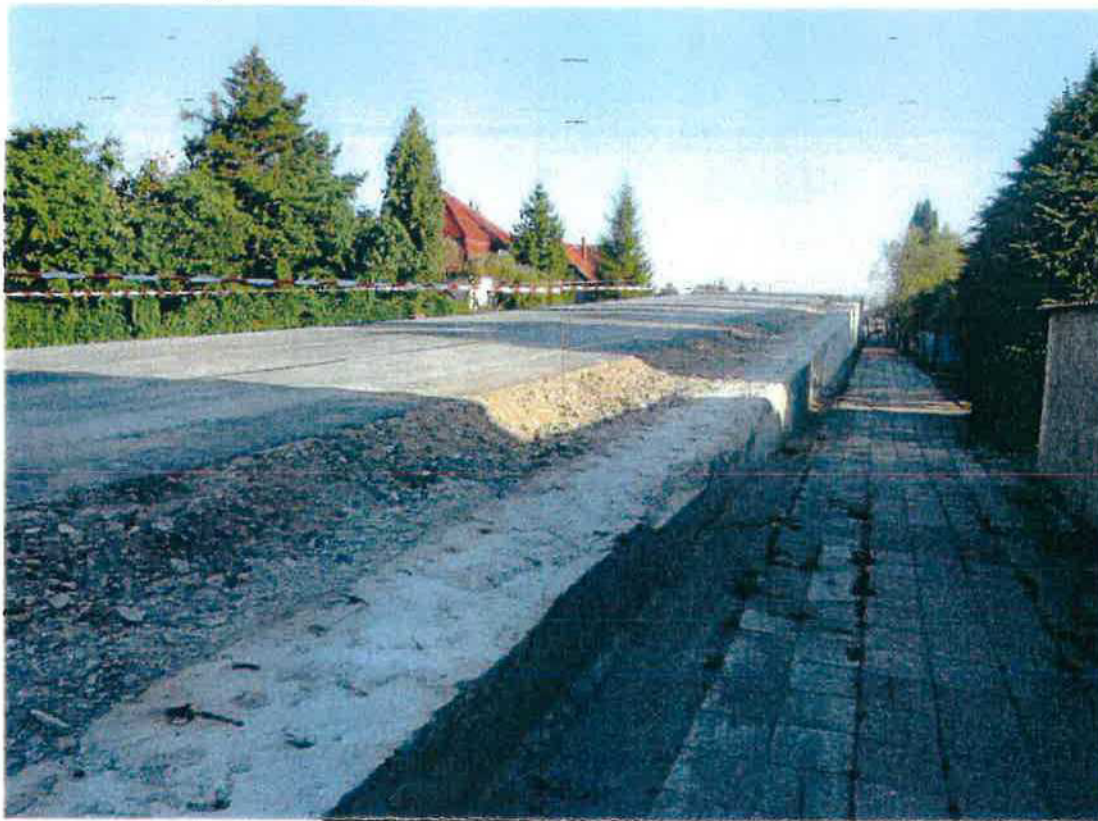
pravá opěrná zeď před O1 – pohled ve směru staničení
