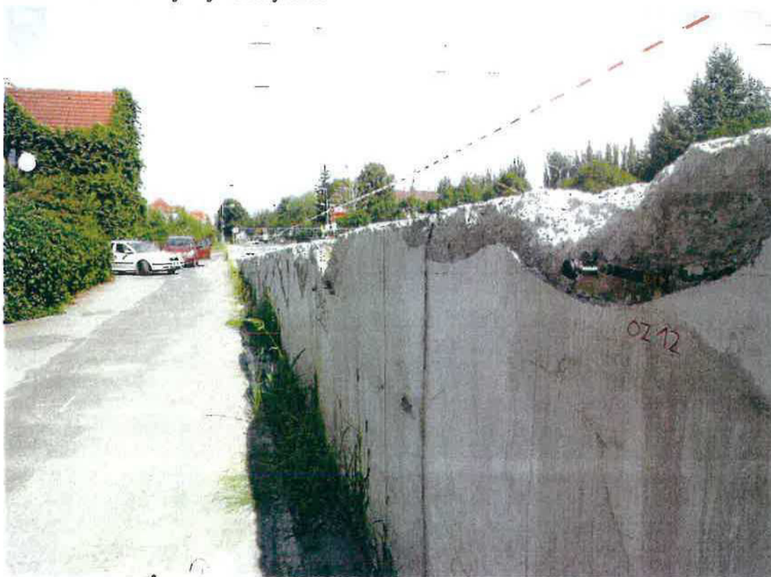
levá opěrná zeď za O10 – pohled ve směru staničení
