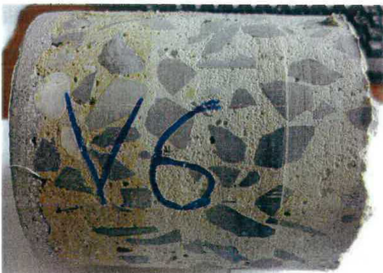
Obr. 2.6 – vývrt V6 z levé opěrné zdi na O10
