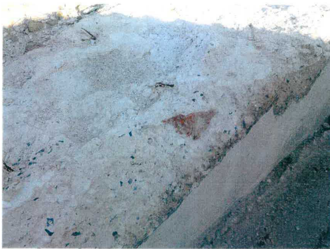
DTTO – ve zdi se objevují kousky cihel
