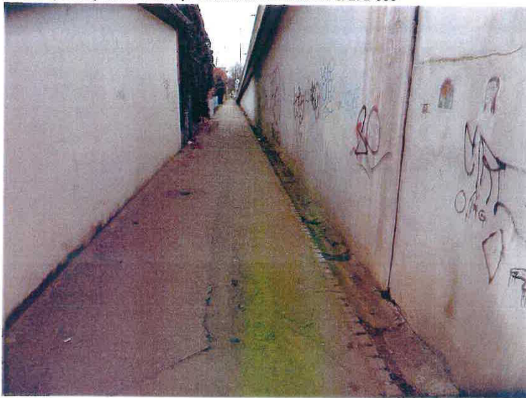
Stávající stav opěrné zdi SO 202
