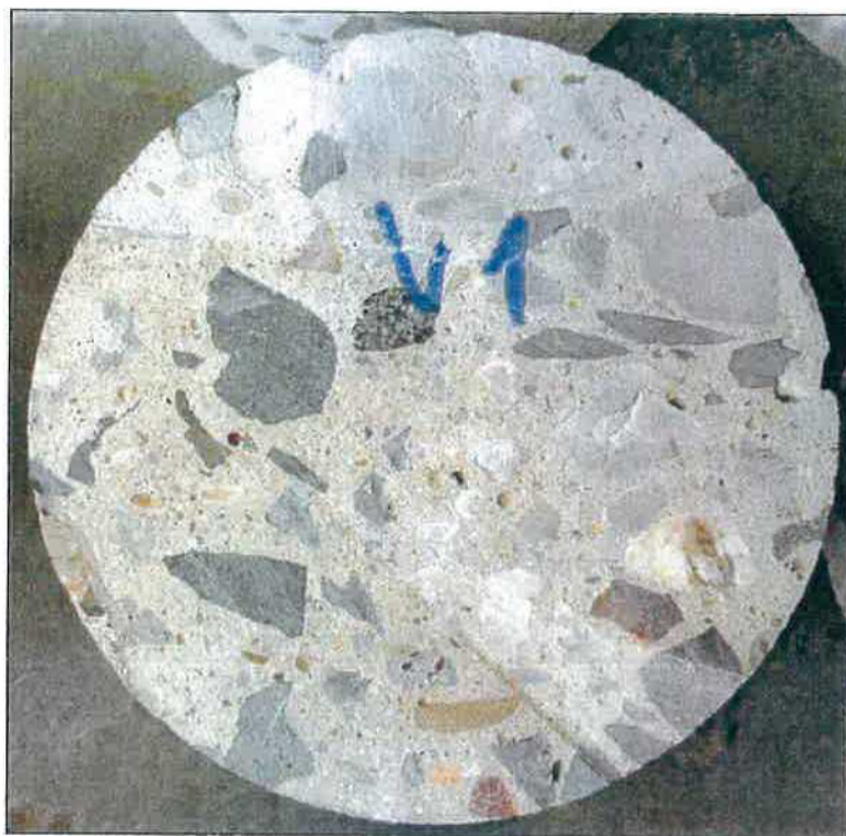
Foto 3: Pohled na líc vývrtu V1 před zkouškou
