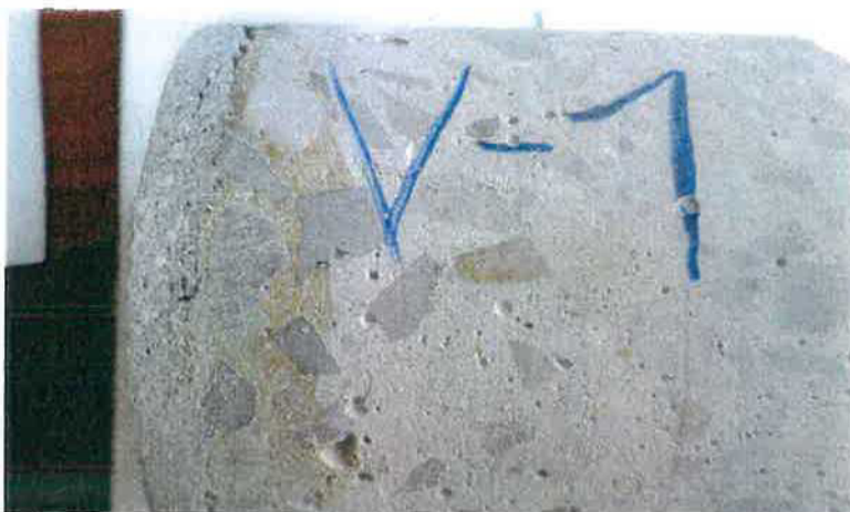
Obr. 2.1 – vývrt V1 z levé opěrné zdi před O1
