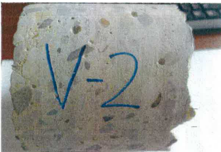
Obr. 2.2 – vývrt V2 z levé opěrné zdi před O1
