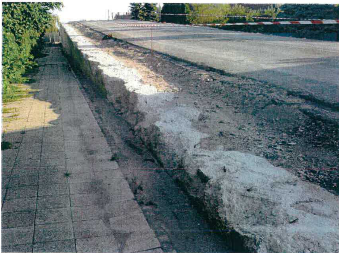
levá opěrná zeď před O1 – pohled ve směru staničení
