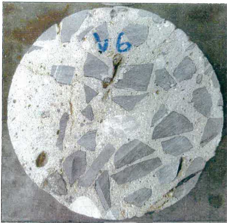
Foto 13: Pohled na líc vývrtnu V6 před zkouškou
