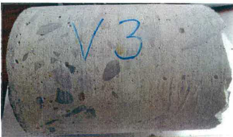
Obr. 2.3 – vývrt V3 z pravé opěrné zdi před O1
