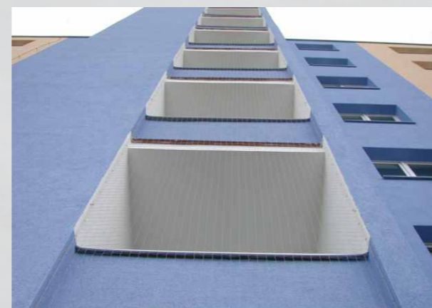
Zakrytí lodžii souvislou sítí S051
