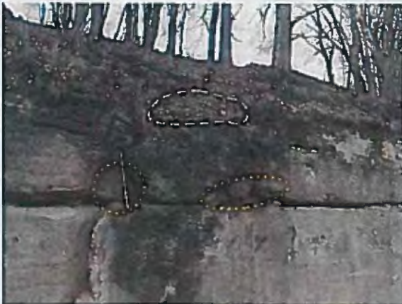
Foto 9: Samostatný skalní blok zcela oddělený od masivu. Blok je pod vlivem vody povrchového odtoku. V jeho zázemí dochází k intenzivnímu zvětvávání a erozi za vzniku volných dutin. Česká geologická služba doporučuje blok podezdit, jak naznačují žlutě tečkované slépy, vyplnit volné dutiny a umožnit drénování vody. Bílý čárkovaný polygon zvýrazňuje svrchní partii, kde je vhodné provést začistění od vegetačního pokryvu a zaplombovat otevřené pukliny tak, aby nedocházelo k zatékání po povrchu stékající vody.
