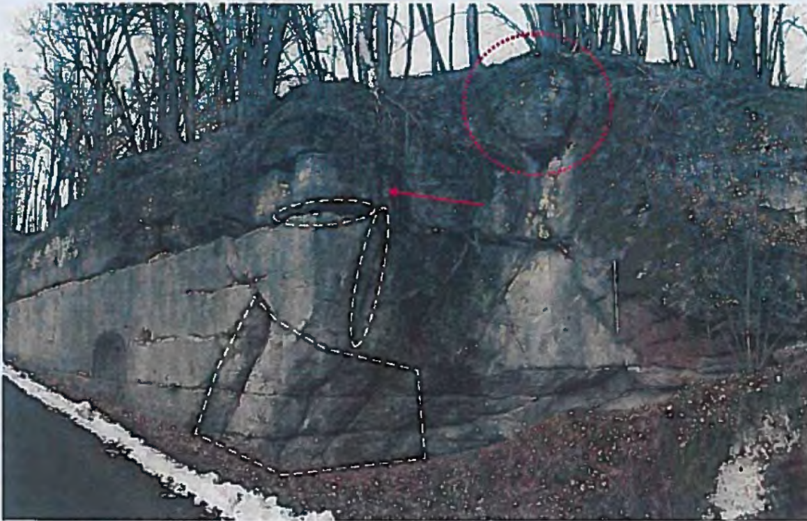
Foto 11: Česká geologická služba doporučuje v této části skalního výchozu odtěžit skalní blok označený červeně tečkovanou kružnicí. Červená šipka ukazuje na břízu uchycenou v rozevřené puklině. Takto uchycené dřeviny ve výchozech jsou pro jejich stabilitu zcela nevhodné. Bílé čárkovaný polygon naznačuje podezdění skalního pilíře pro udržení jeho stability. Dále je vhodné vyzdít či vyspárovat otevřené pukliny v místech, kde tak naznačují čárkované elipsy.
