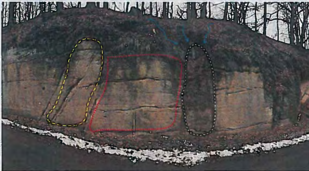
Foto 2: Skalní objekt uprostřed zvýrazněný červeným tečkovaným polygonem představuje skalní šupinu oddělenou od masivu podél pukliny rovnoběžně probíhající s linií zářezu silnice. Napravo od tohoto objektu dochází k silnému působení povrchového odtoku vody a intenzivní erozi a zvětvávání, jak naznačují modré šipky a bílý čárkovaný polygon. Odtěžením skalní šupiny může dojít k narušení stability objektu vlevo vyznačeného žlutým čárkovaným polygonem. Česká geologická služba doporučuje tento skalní objekt monitorovat a v případě progresivních pohybů provést jeho stabilizaci nebo odtěžení.
