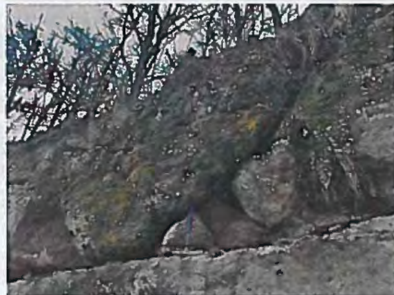
Foto 10: Blíží pohled na volné dutiny vzniklé intenzivním zvětváváním a erozí zatékáním vody povrchového odtoku.
