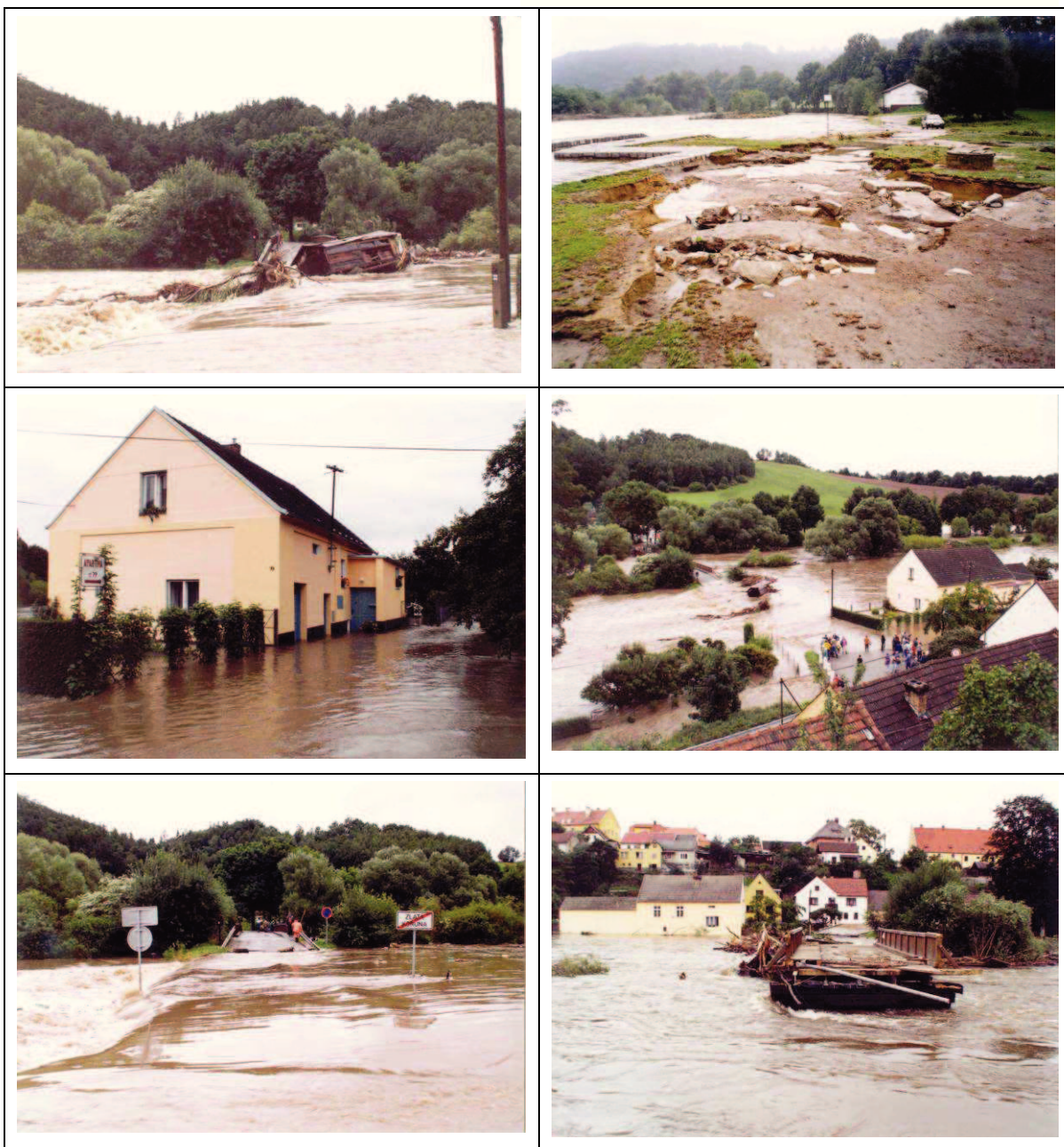
Obrázek 15 – Povodně ve Zlaté Koruně 2002
