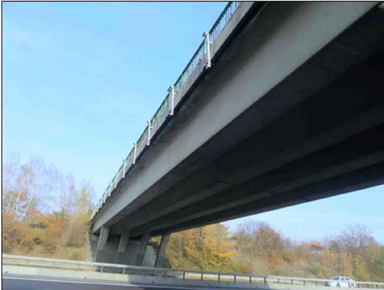
podhled 2. pole od P3
