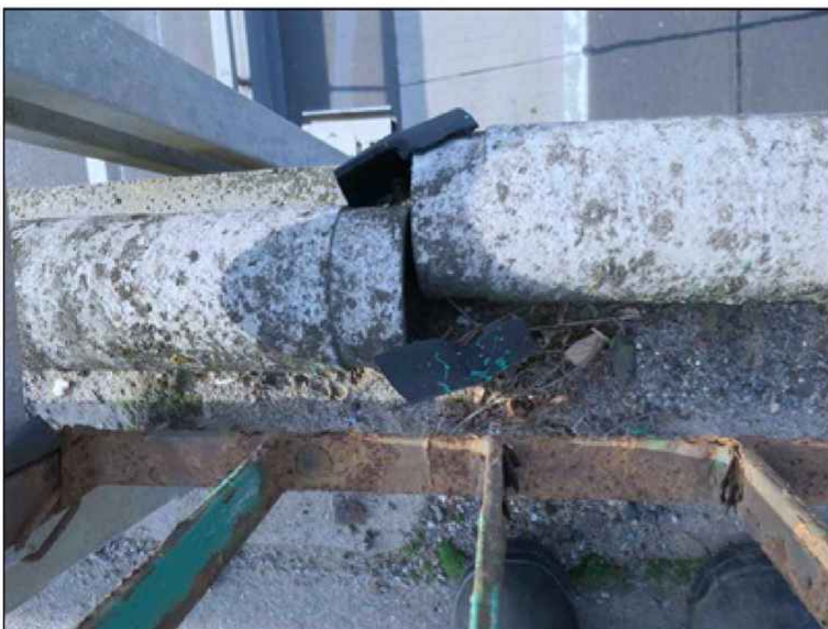
detail styku chrániček na pravé římse
