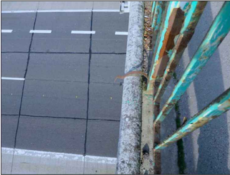
uvolněné kotvení chráničky
