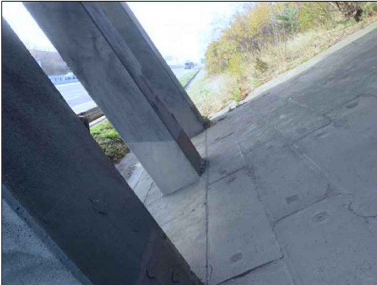
pohled na vzpěry P2
