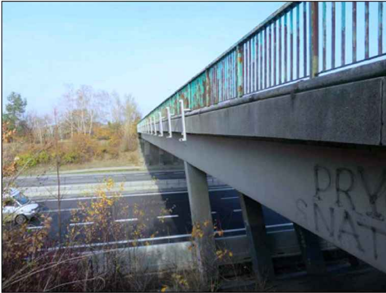
pravý bok mostu
