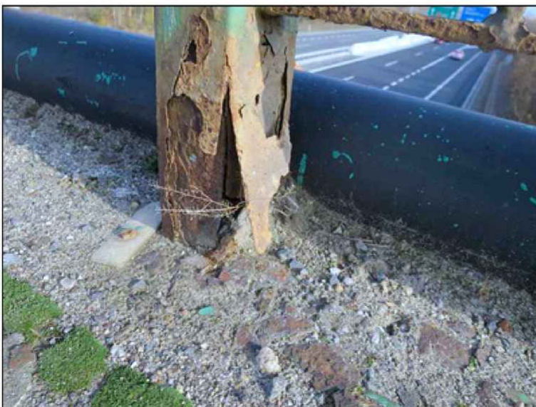
koroze zábradlí
