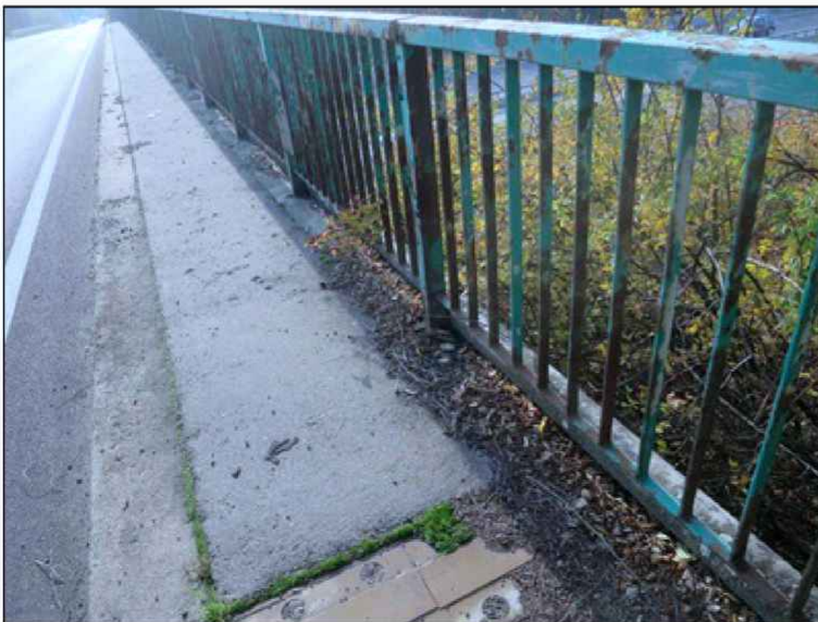
koroze zábradlí
