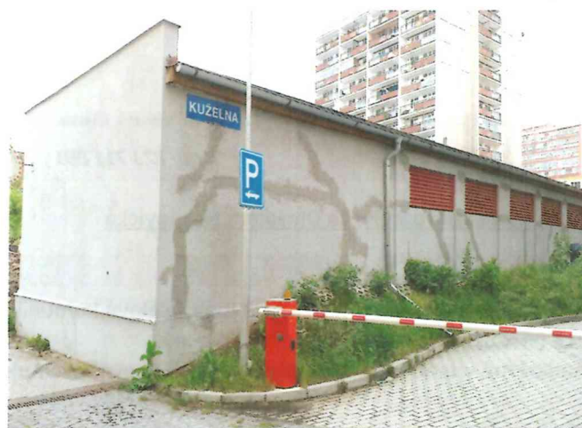
Stav objektu k 23.5.2019
