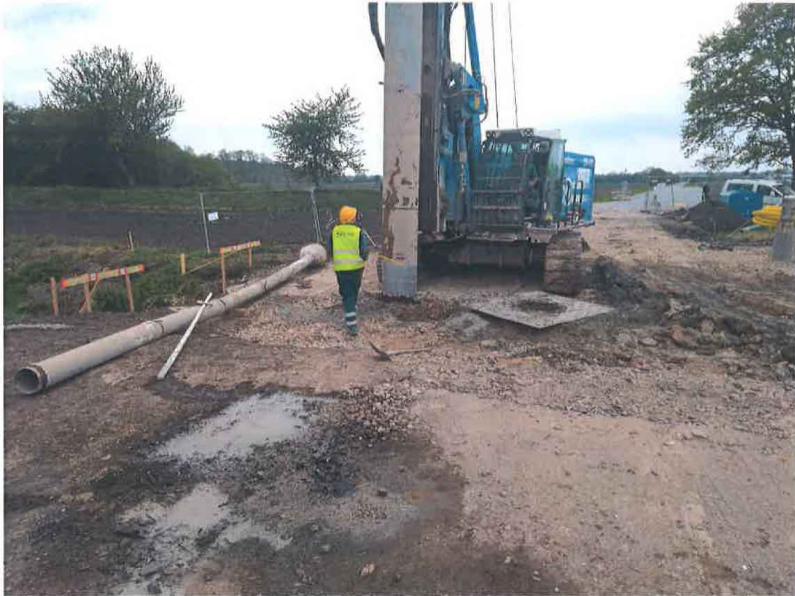
Využití zásypu pro přejezd vrtné soupravy
