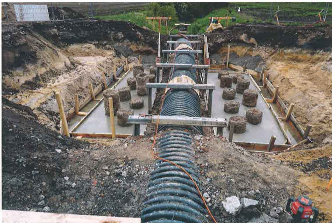
Základy mostu po odstranění zásypu
