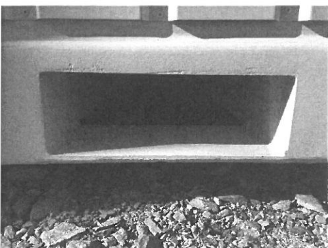
Obrázek 10 Lyžiny – otvory pro vysokozdvizný vozík
