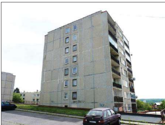
Panelový bytový dům
