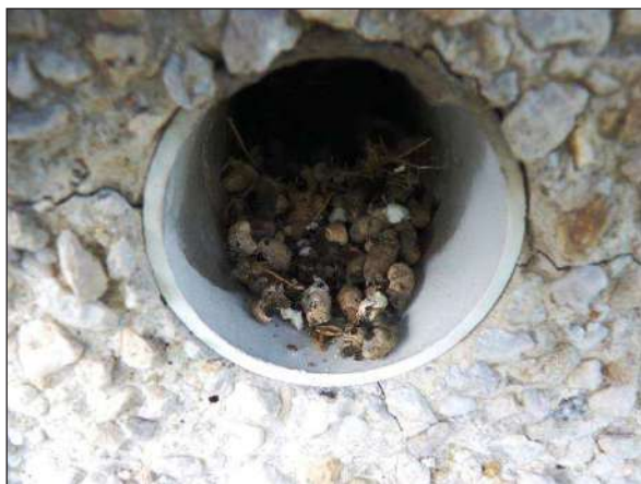
Trus rorýse obecného v ústí ventilačního otvoru
