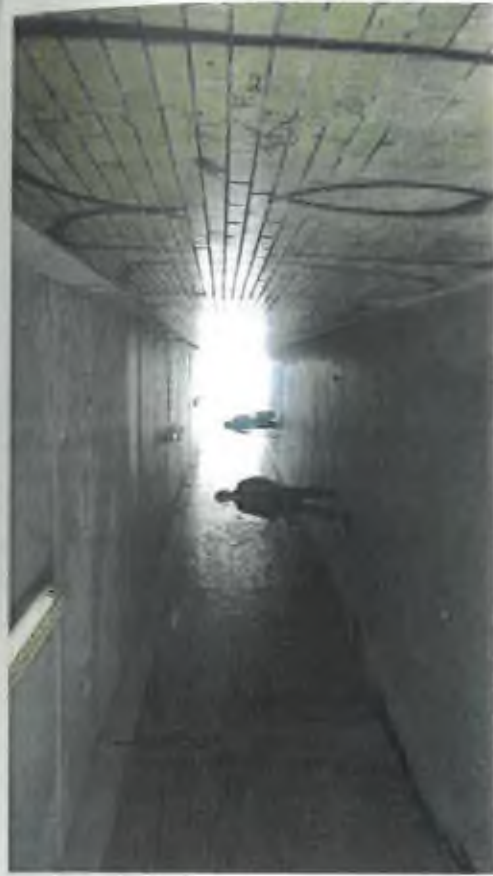
Obr.2 Stávající podchod k nemocnici pod ulicí Vídeňská
