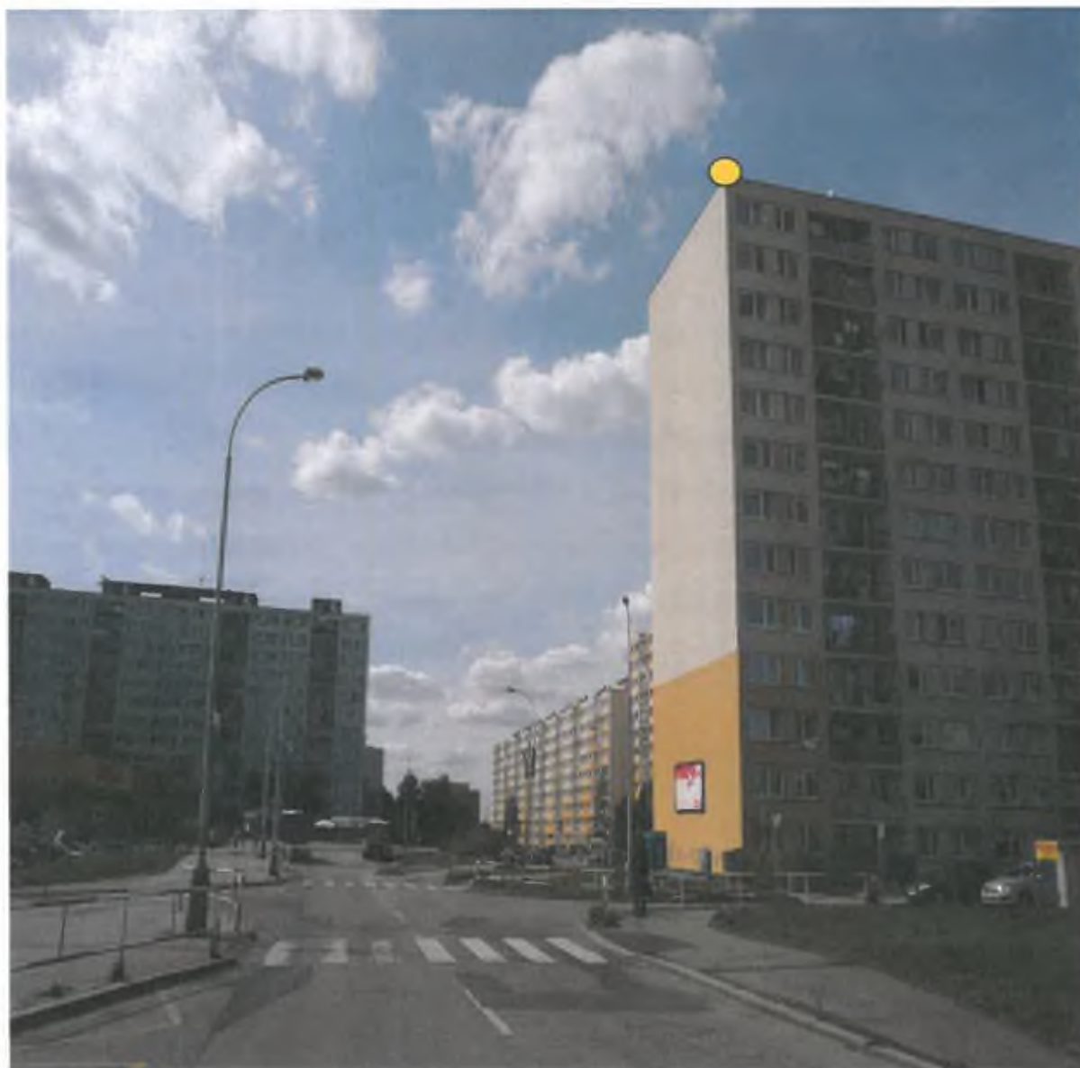
Příklad umístění kamerového stanoviště na střeše objektu
