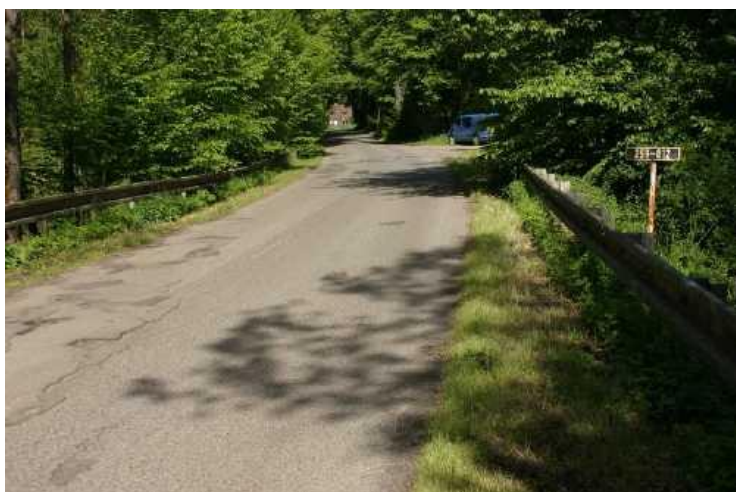
Celkový pohled na most ve směru staničení
