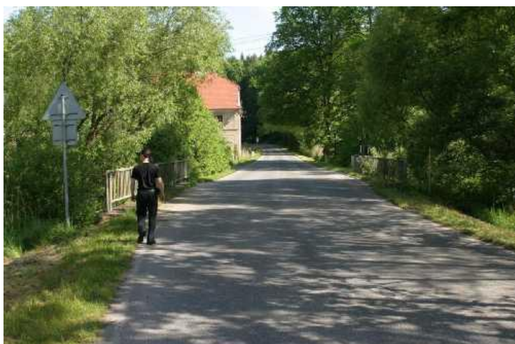
Celkový pohled na most ve směru staničení
