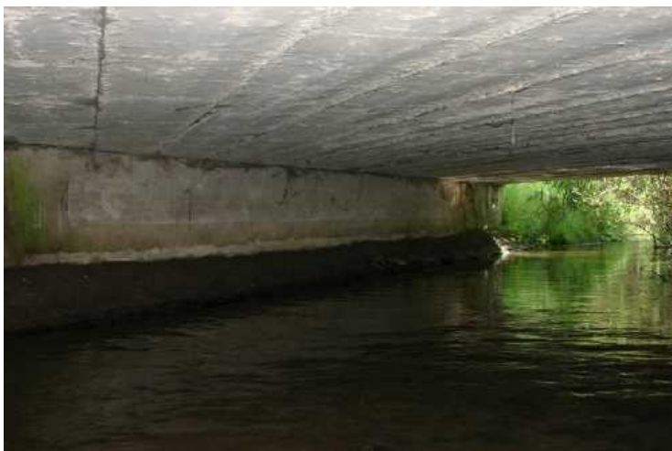
Pohled na opěru 2 a podhled nosné konstrukce.
