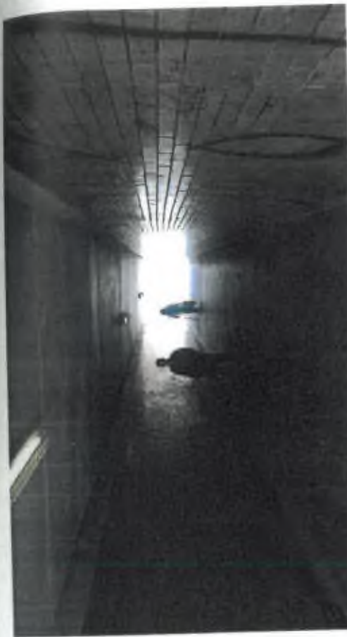
Obr.2 Stávající podchod k nemocnici pod ulicí Vídeňská
