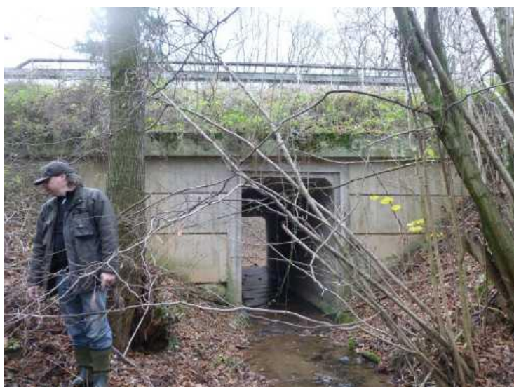
Pohled na vtok
