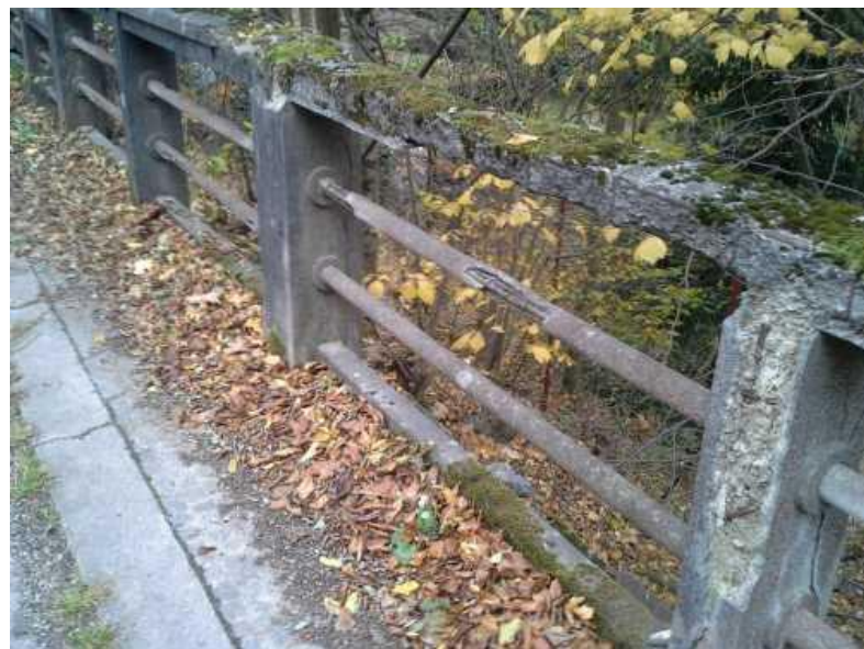
Most ev. č. 288-006 přes řeku Kamenici u Spálova
