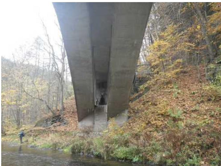
Podhled nosné konstrukce - hlavní nosné oblouky - pohled z levého břehu
