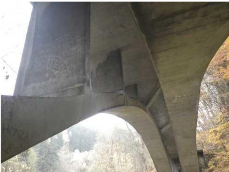
Podhled nosné konstrukce
