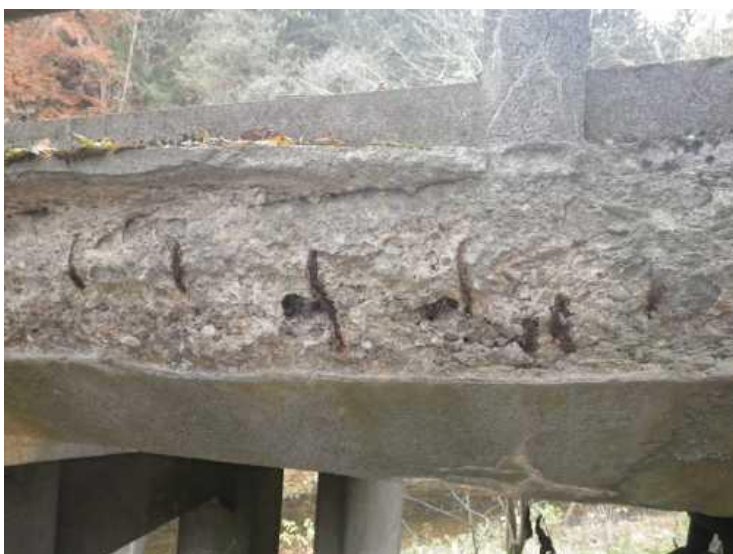
Rozpad okrajů NK / říms
