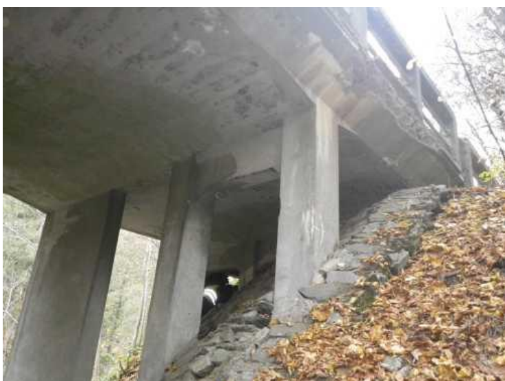
Uspořádání na levobřežním konci mostu - pohled z výtokové strany
