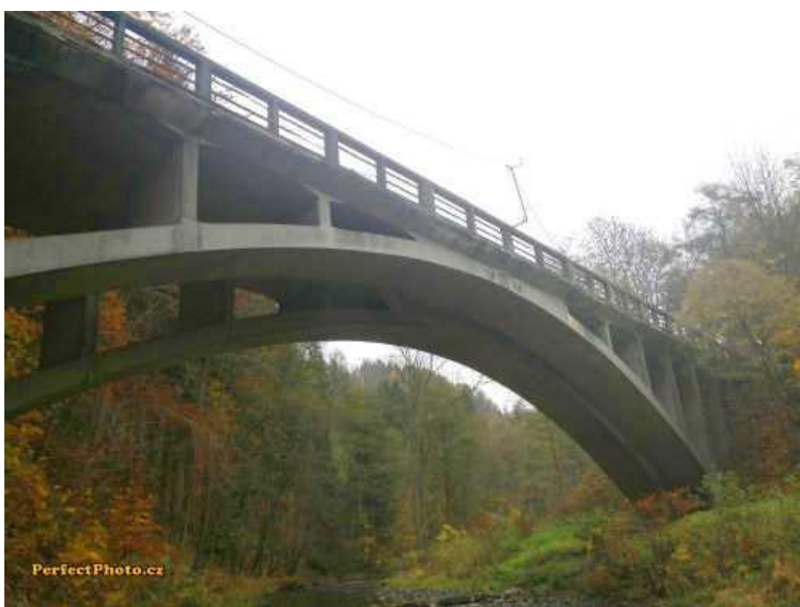
Boční pohled na most - z výtoku
