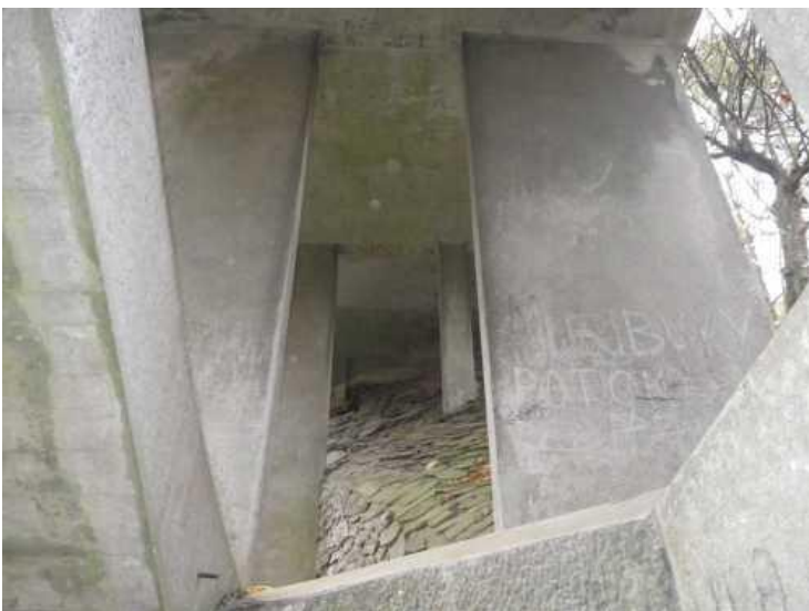
Podhled nosné konstrukce na levobřežní opěře
