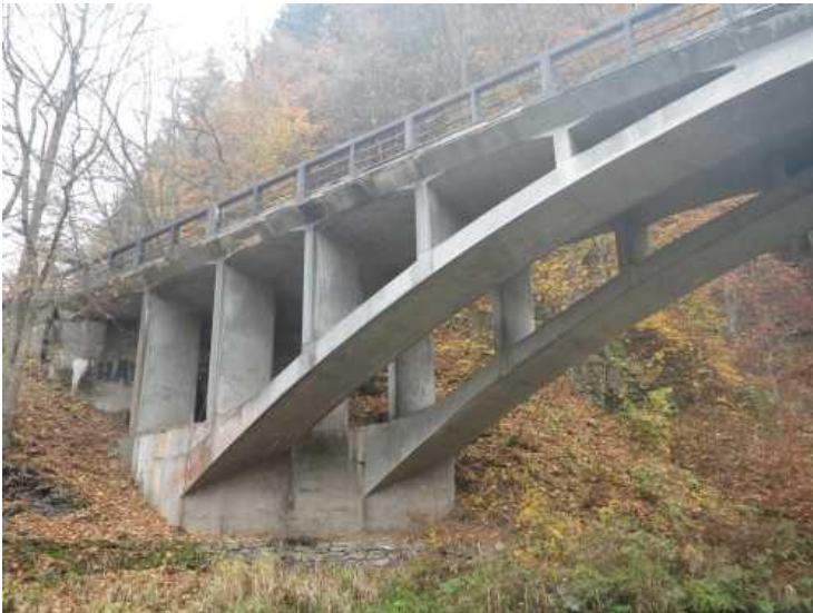
Pohled na pravobřežní opěru
