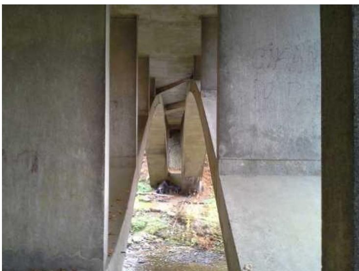
Podhled nosné konstrukce
