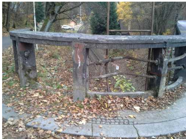
Most ev. č. 288-007 přes trať ČD u Spálova
