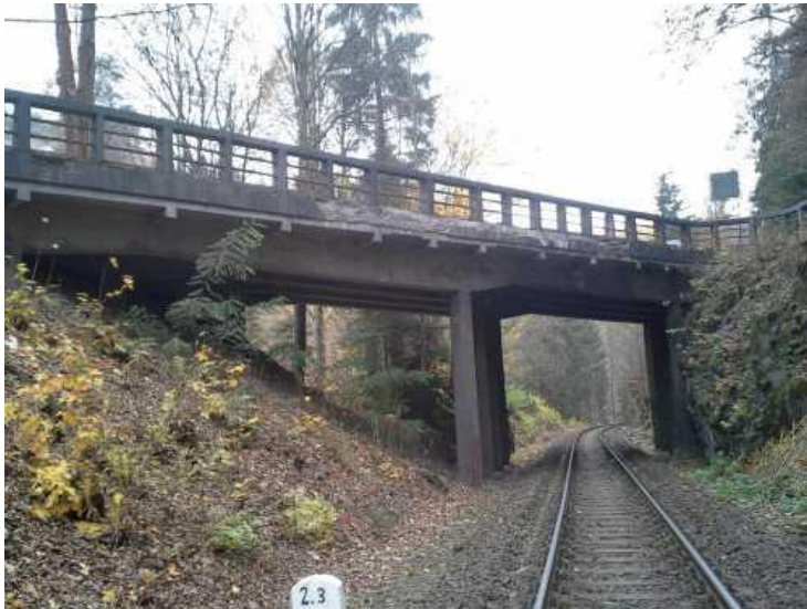
Pohled na most z pravé strany
