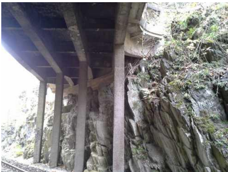
Pohled na vnitřní podpěru 4 a pohled NK
