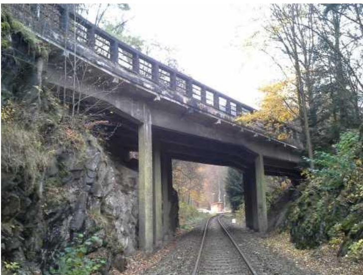
Pohled na most z levé strany
