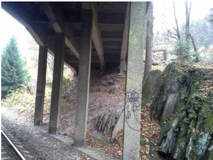
Pohled na vnitřní podpěru 3 a pohled NK
