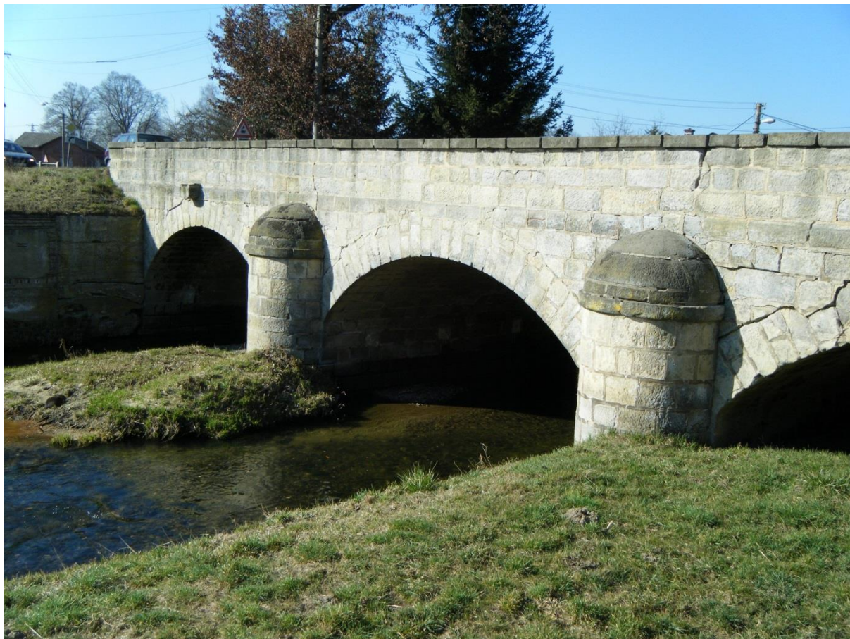
Most ev. č. 268-024 přes Svitávku v Zákupích
