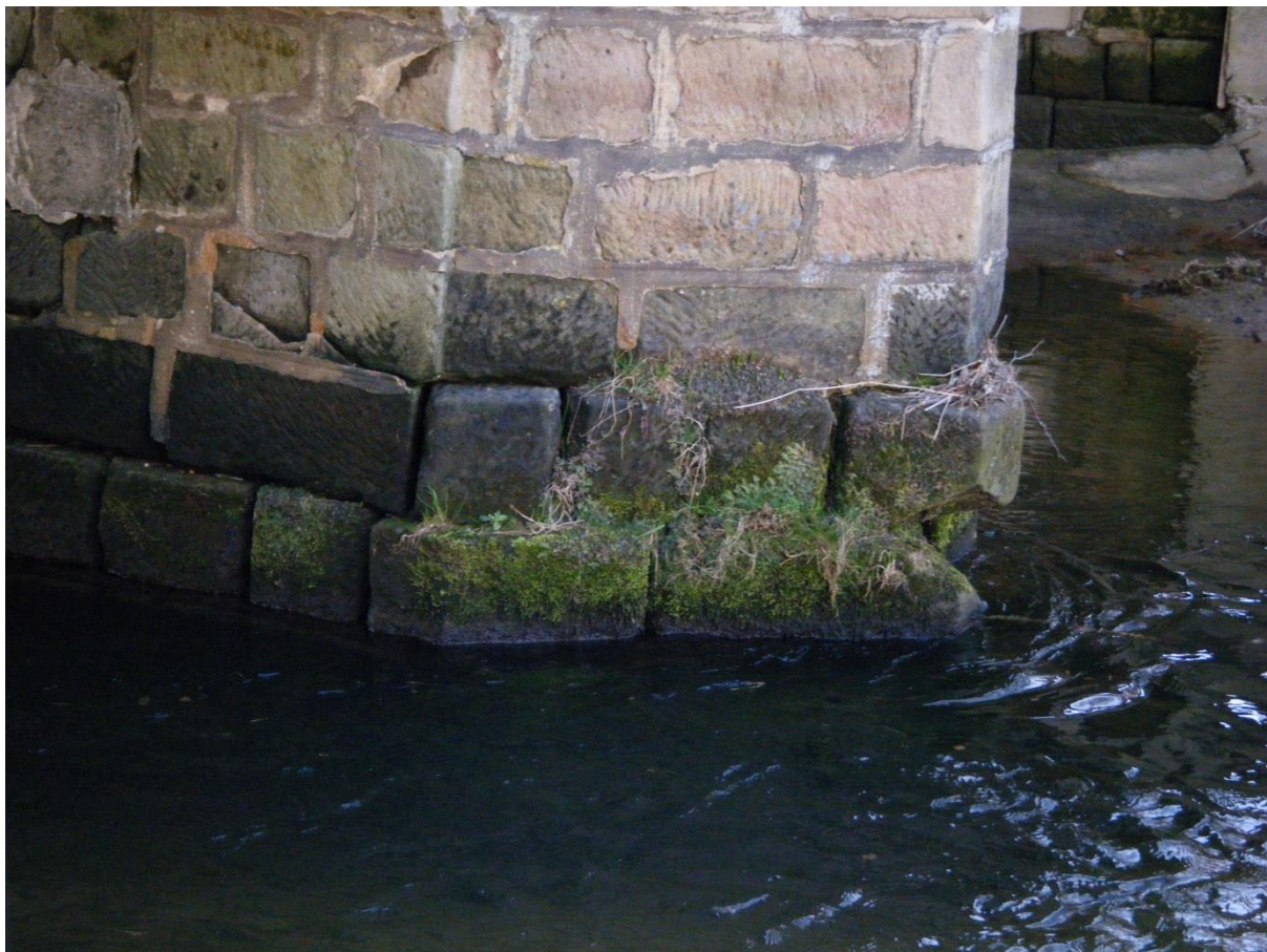
Most ev. č. 268-024 přes Svitávku v Zákupích
