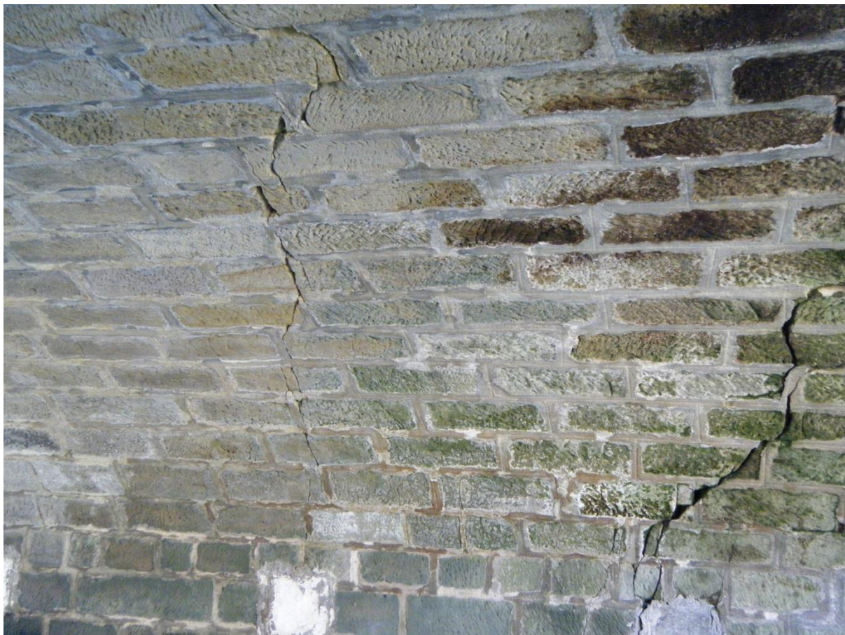
Most ev. č. 268-024 přes Svitávku v Zákupích
