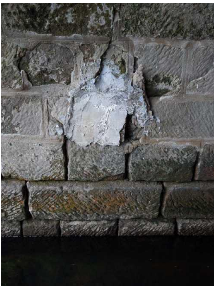
Detail opravy zdiva na opěře 4 vlevo.
