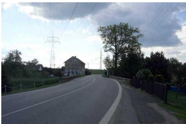
Celkový pohled na most ve směru staničení
