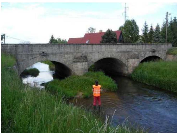
Pohled na most zleva - zanesení koryta vodoteče
