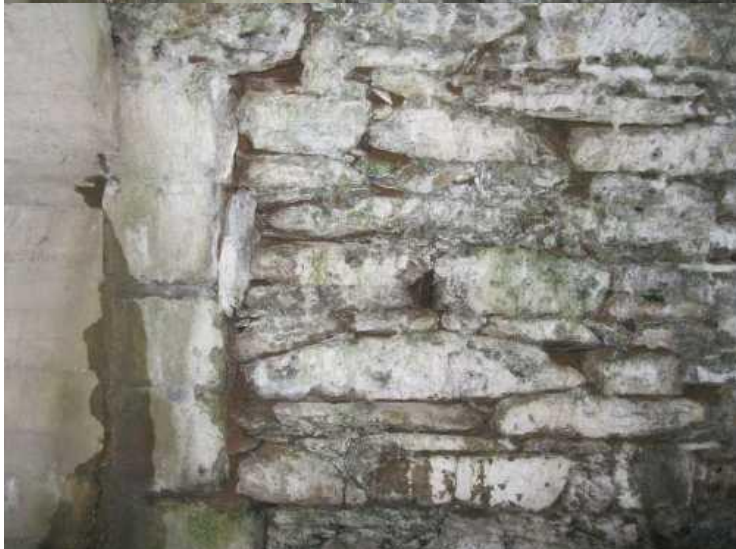
Styk betonové a klenbové části
