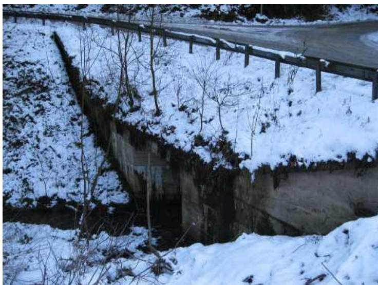
Pohled na vtok
