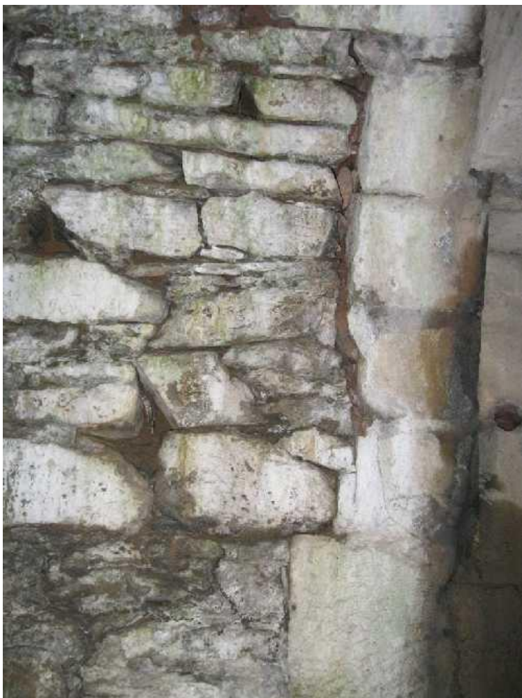
Styk betonové a klenbové části
