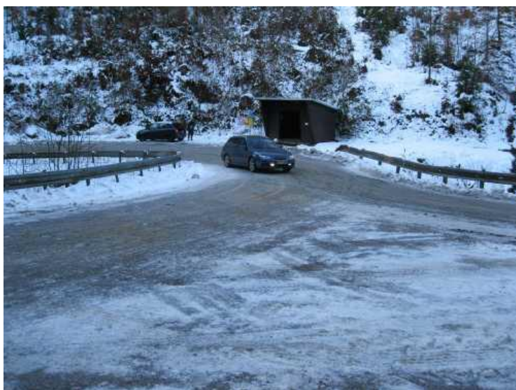
Celkový pohled proti směru staničení
