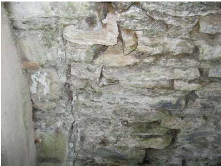
Styk betonové a klenbové části
