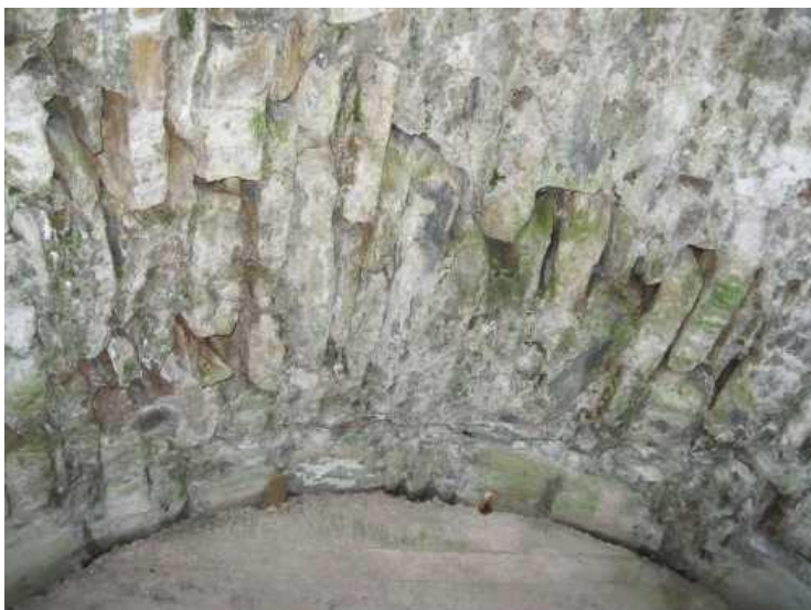
Styk betonové a klenbové části
