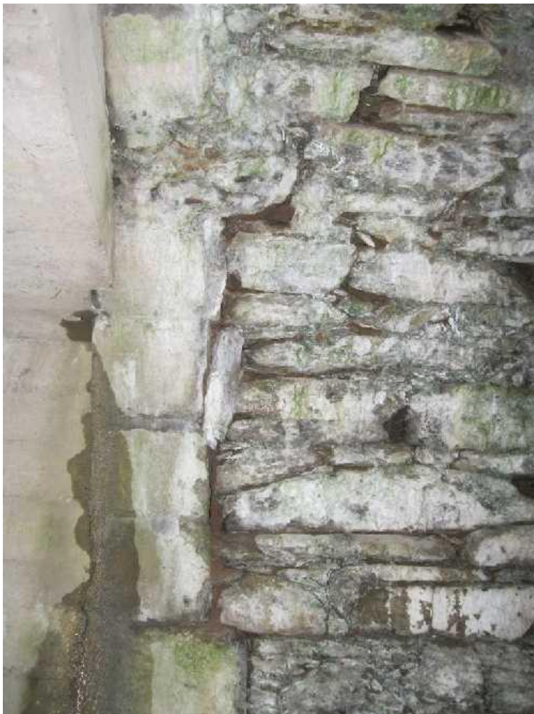
Styk betonové a klenbové části
