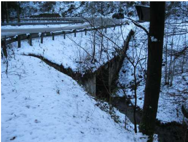
Pohled na vtok
