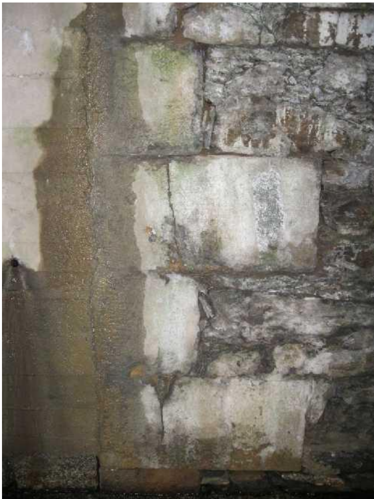
Styk betonové a klenbové části
