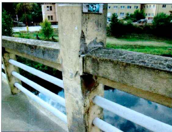
odlupování nátěru. Na ocelové výplni lokálně korozí.
