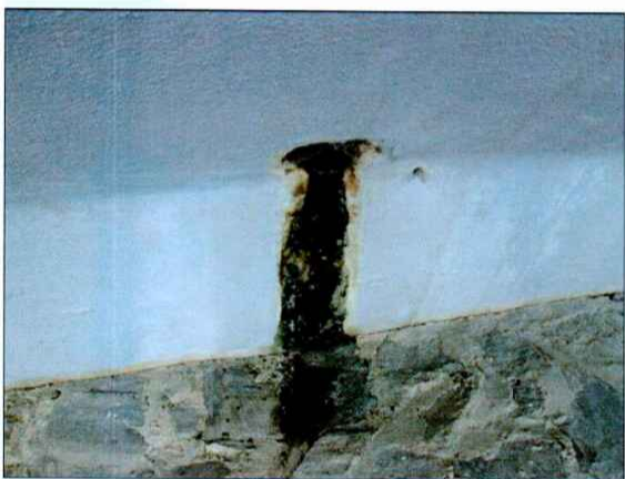
odlupování nátěru. Na ocelové výplni lokálně korozí.
