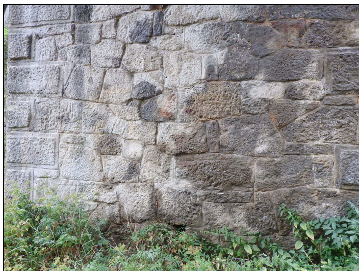
Foto Ā. 4 Ā Opěra O 01 Ā prŭsaky vody s vřluhy pojiva, povrĀovň zvěträvänřzdiva
