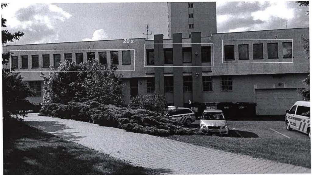
Pohled na okna – pravá strana budovy
