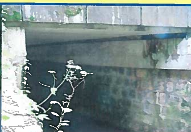
Pohled na bok mostu
