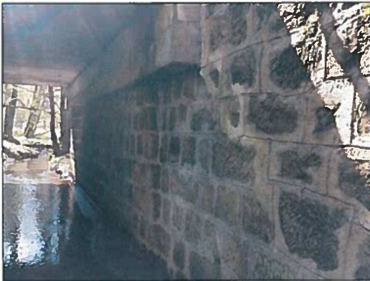
Pohled na OP2
