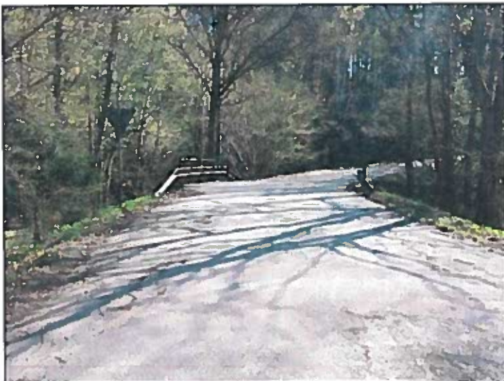
Celkový pohled proti směru staničení
