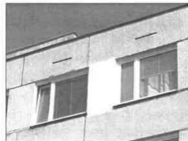
Detail atiky s ventilačními otvory
