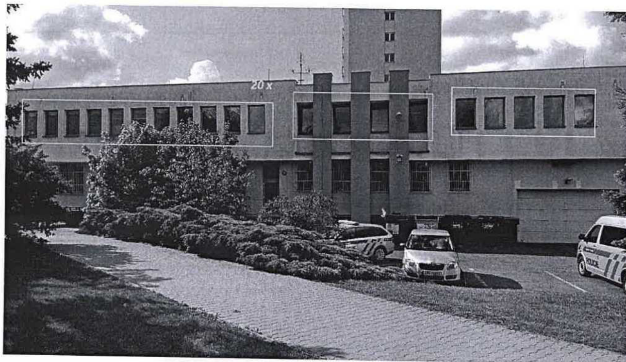
Pohled na okna – pravá strana budovy
