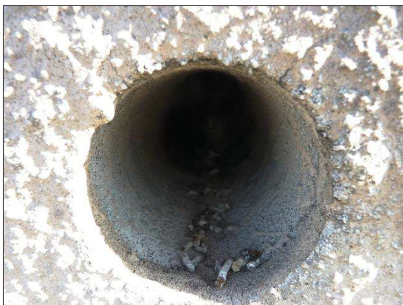
Trus drobných pěvců v ústí ventilačního otvoru
