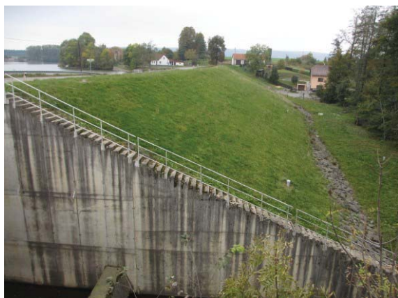
Vzdušní líc hráze s patním drénem
