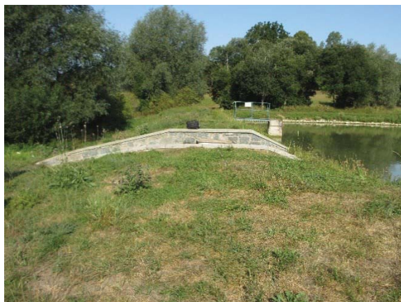
Hráz s bezpečnostním přelivem
