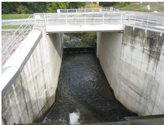
Vývar sdruženého objektu
