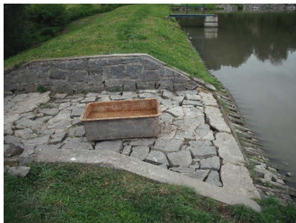
Detail bezpečnostního přelivu
