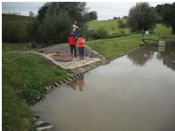
Bezpečnostní přeliv v levém zavázání
