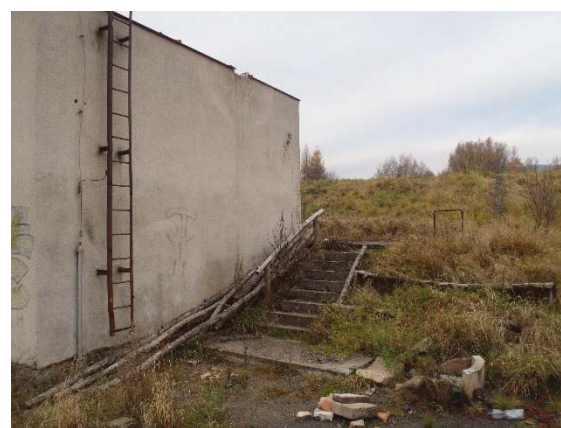
Podhled od čerpací stanice na vzdušní líc hráze
