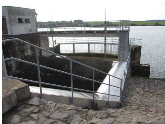
Pohled na provozní a boční bezpečnostní přeliv sdruženého objektu
