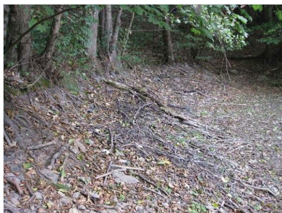
Pohled na vzdušní líc hráze
