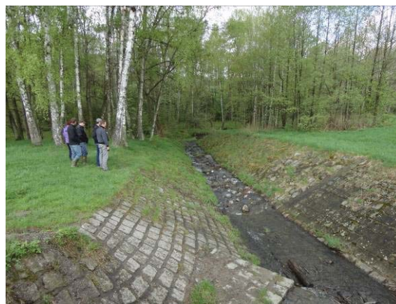
Odpad od bezpečnostního přelivu
