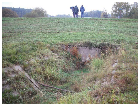
Vyústění spodní výpusti v podhrází
