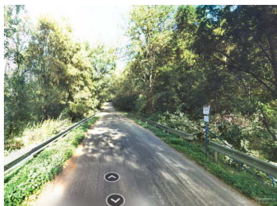
Násypové silniční těleso
