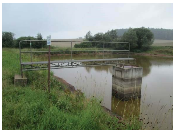
Požerák s ocelovou lávkou
