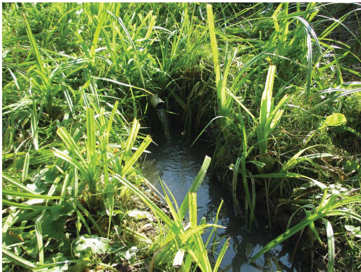
Obrázek 3. Osazení trubky DN 40 mm v místě vývěru vody na vzdušném líci hráze
