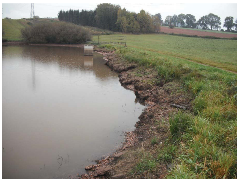
Obrázek 3. Pohled na návodní líc hráze
