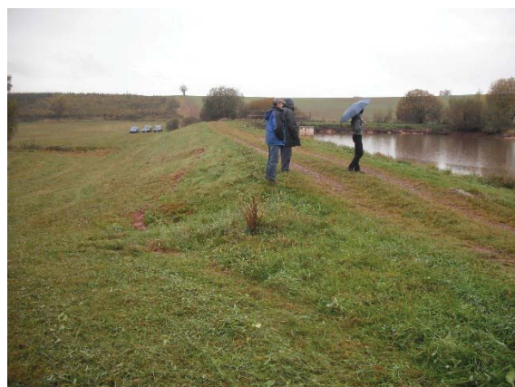
Bezpečnostní přeliv – snížená část terénu
