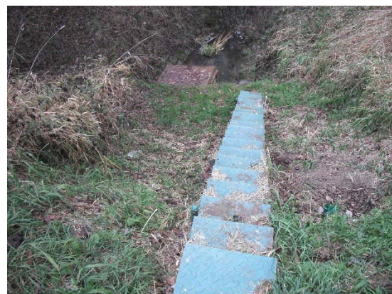
Ocelové schody na vzdušném líci
