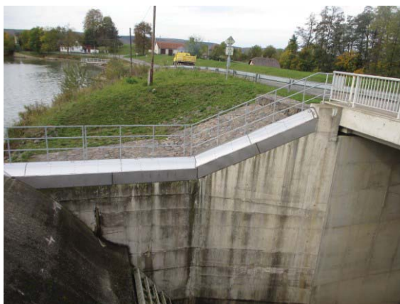
Návodní líc hráze a boční bezpečnostní přeliv sdruženého objektu
