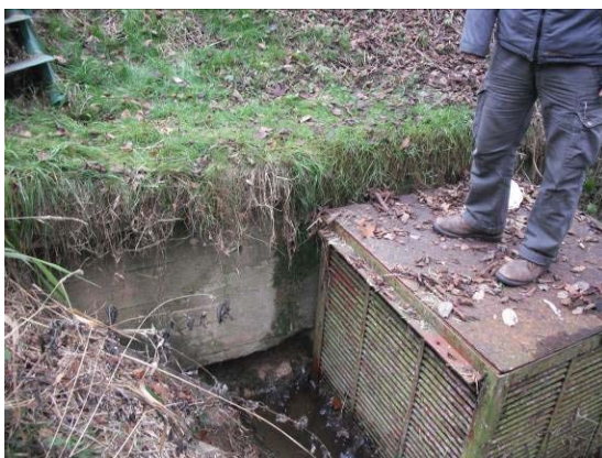
Česlicová klec na vyústění potrubí v podhráží
