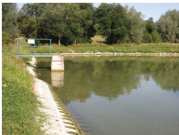
Opevnění návodního líce polovegetačními tvárnicemi
