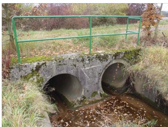
Spadiště bezpečnostního přelivu navazující na trubní propustek
