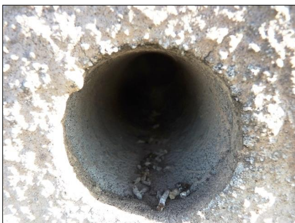
Trus drobných pěvců v ústí ventilačního otvoru
