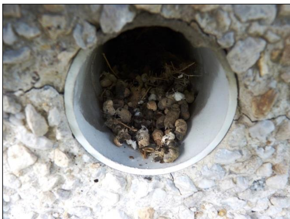
Trus rorýse obecného v ústí ventilačního otvoru
