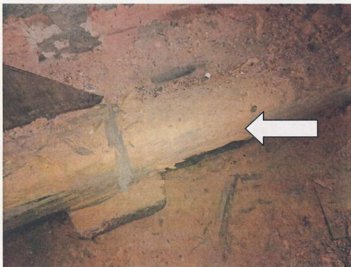
Napadení vazného trámu.
