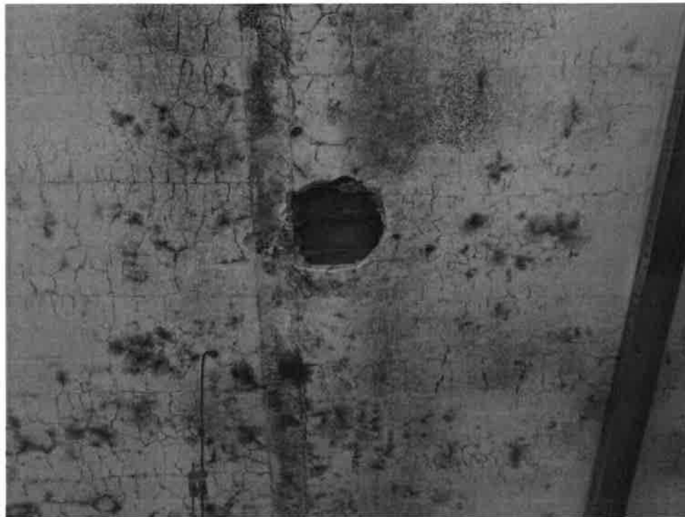
obrázek č.3 Pohled na strop nad 2.NP
