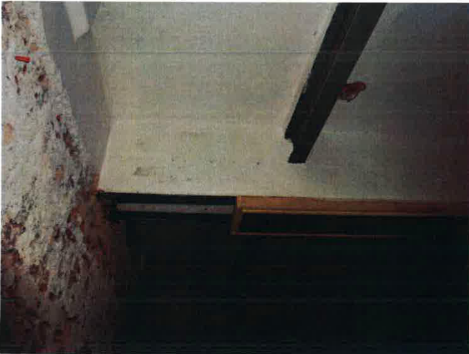
obrázek č.2 Pohled na strop nad 1.NP z valené cihelné klenby uložené do ocelových I nosníků dodatečně podchycené ocelovým trámem a ocelovým průvlakem
