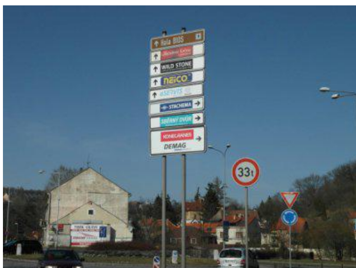
Ouvalová ulice dva sloupky č. 11 p. č. 1887/6 k. ú. Slaný vlastník město - hala BIOS
