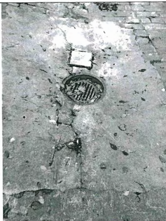
Obr. 3. Dvorní vpust a povrch podlahy dvorku
