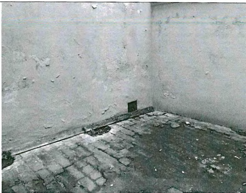
Obr. 9. Rozsah degradace povrchu opěrné zdi ve dvorní části (vpravo od vstupu)
