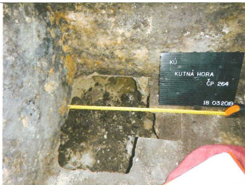
Obr. 04 Celkový pohled ústí propadu
