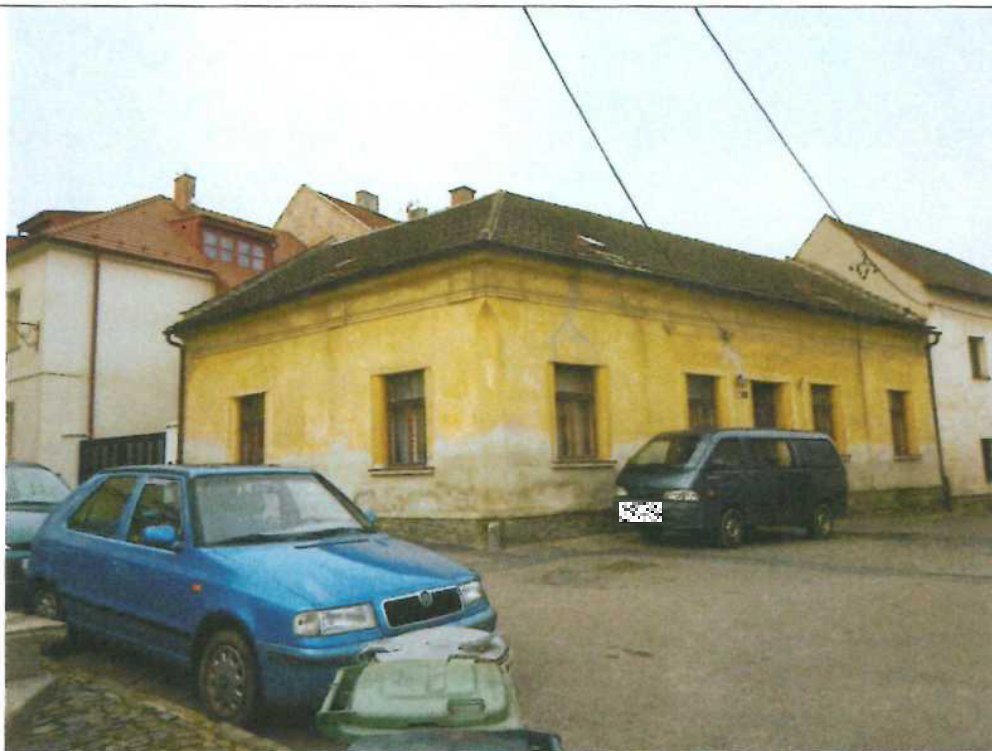
Obr. 01 Celkový pohled na dům č. p. 264 od jihu
