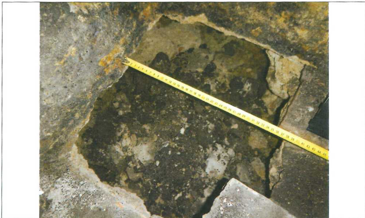
Obr. 05 Detail ústí propadu
