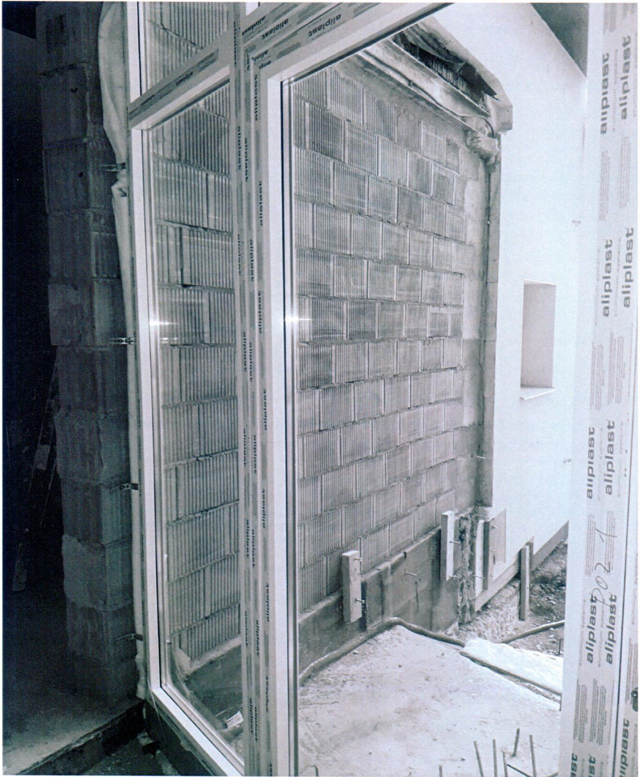
Dozdívka a zateplení u zadního vstupu
