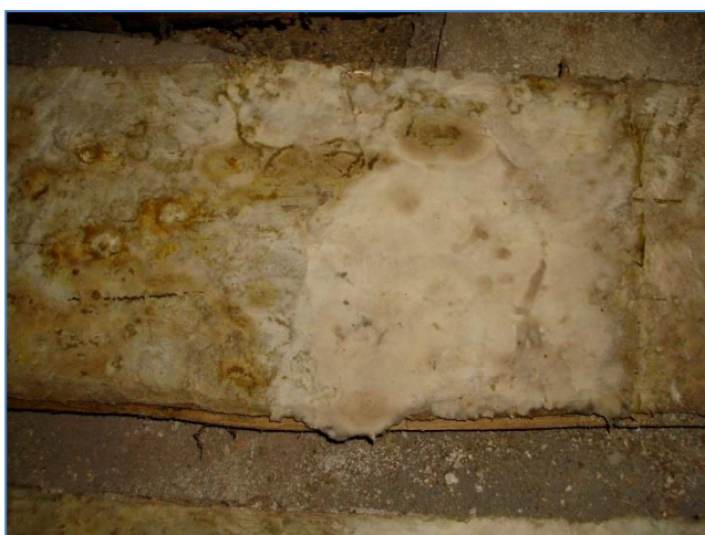
Obr.č.7: detail aktivního mycelia dřevomorky domácí
