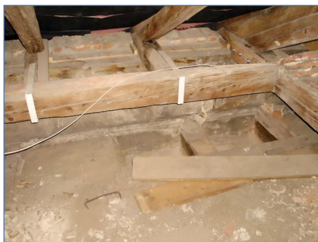
Obr.č.4 : celkový pohled na sondu S5
