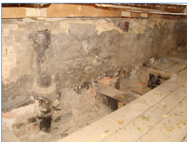
Obr.č.3: celkový pohled na sondu S3
