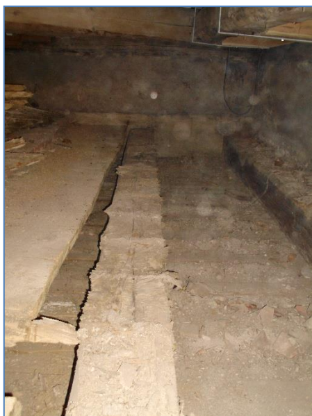
Obr.č.5: celkový pohled na sondu S4
