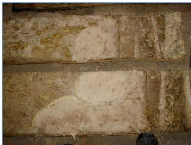
Obr.č.6 : mycelium dřevomorky domácí na rubové straně záklopových fošen
