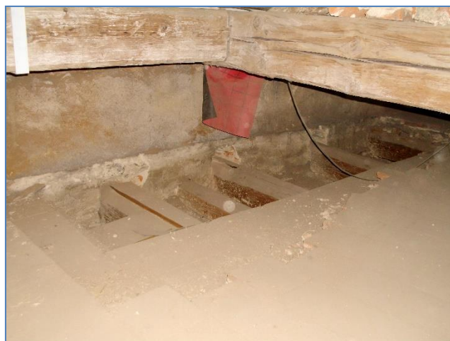
Obr.č.2 : celkový pohled na sondu S2
