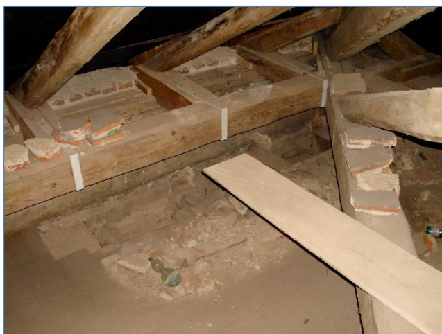
Obr.č.1: celkový pohled na sondu S1
