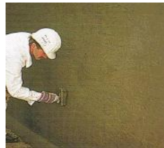
4. celoplošný nátěr – 2 vrstvy
