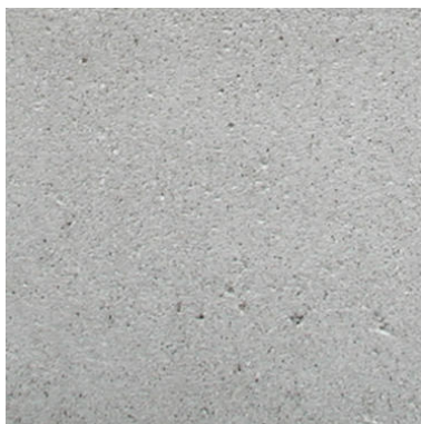
ilustrační fotografie: pískovaný pohledový beton prefabrikovaného panelu
