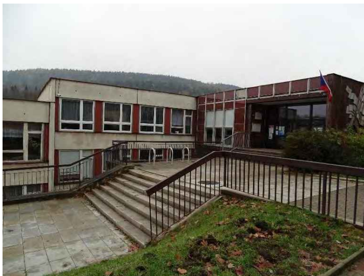
S11 – nová siréna na budově školy
