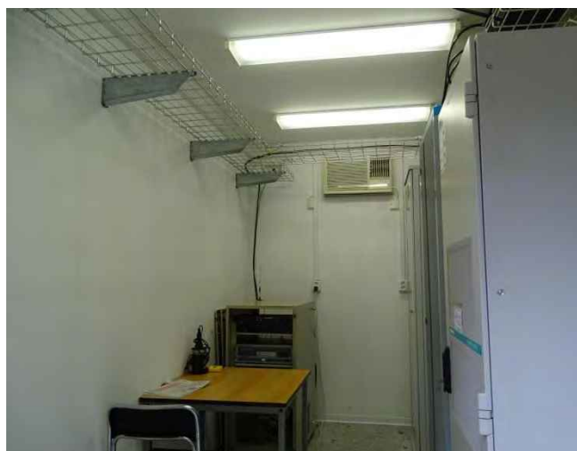
Obr. P1-3 – umístění skříně převaděče a trasa anténního kabelu v kontejneru
