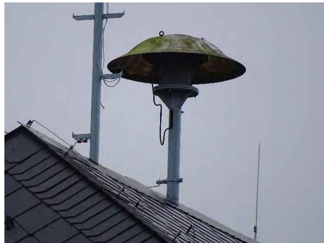
S20– stávající stožár sirény s přírubou
