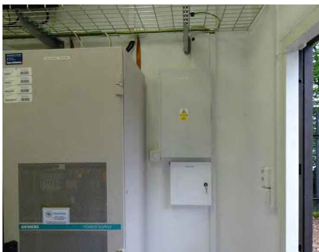
Obr. P1-4 – rozvaděč R-TU Matra a trasa napájecího a zemnicího kabelu
