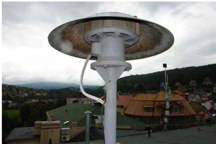
S19 – stávající stožár sirény s přírubou
