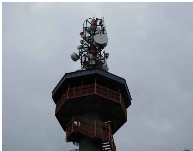
Obr. P2-2 – umístění antény pod vyhlídkovým patrem
