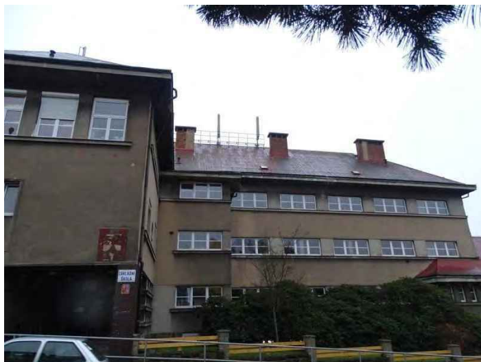
S3 – nová siréna na budově školy
