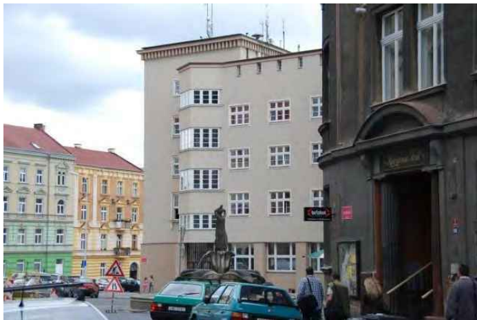
S19 – stávající siréna na budově MMD
