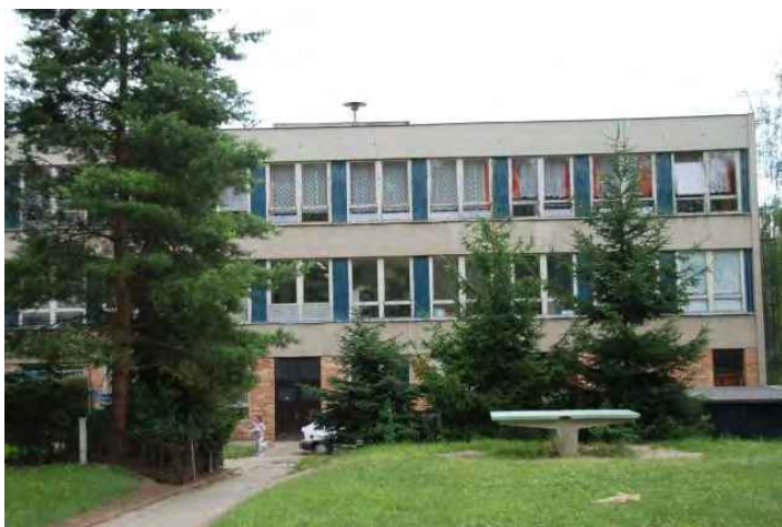
S12 – rotační siréna na budově školy
