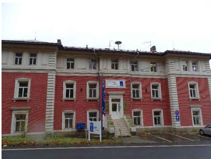
S4 – stávající siréna na budově školy
