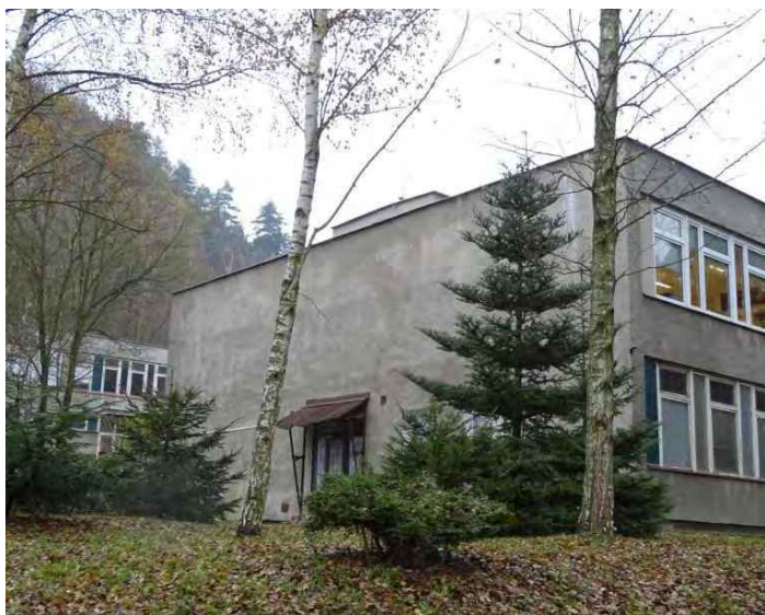
S1 – nová siréna na budově školy
