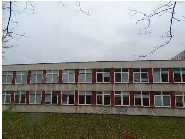
S18 – stávající siréna na škole
