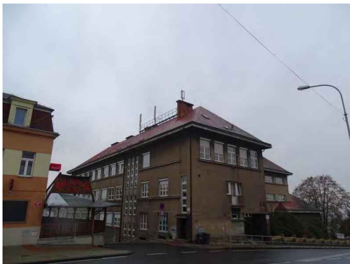
S3 – nová siréna na budově školy
