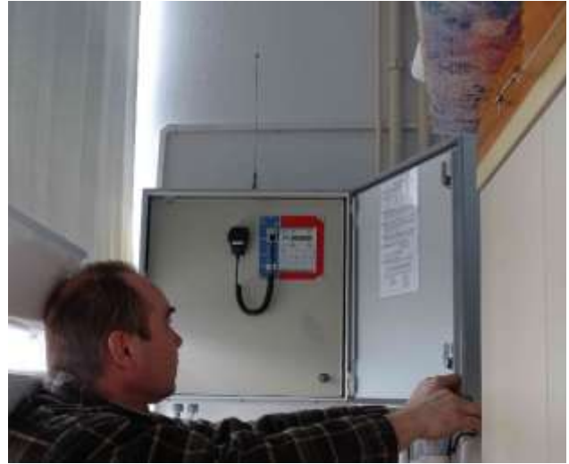
ES.22 – stávající siréna Maestro s ovládacím panelem a mikrofonem
