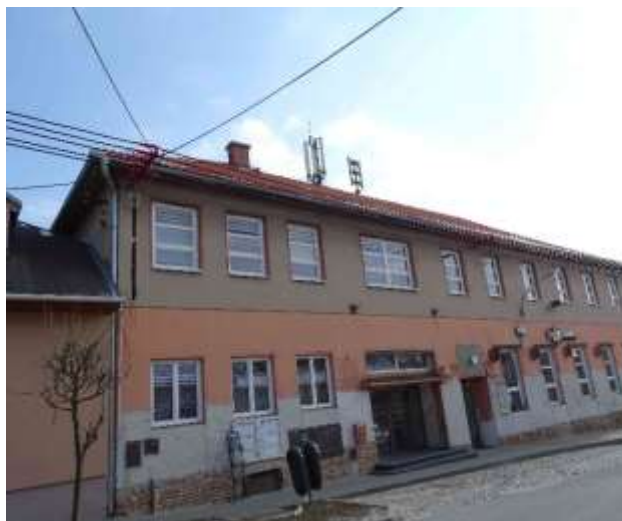
ES.1 – střecha KD, umístění stožáru s ozvučnicemi
