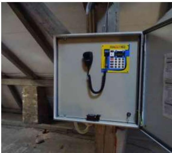
ES.9 – stávající siréna Maestro s ovládacím panelem a mikrofonem
