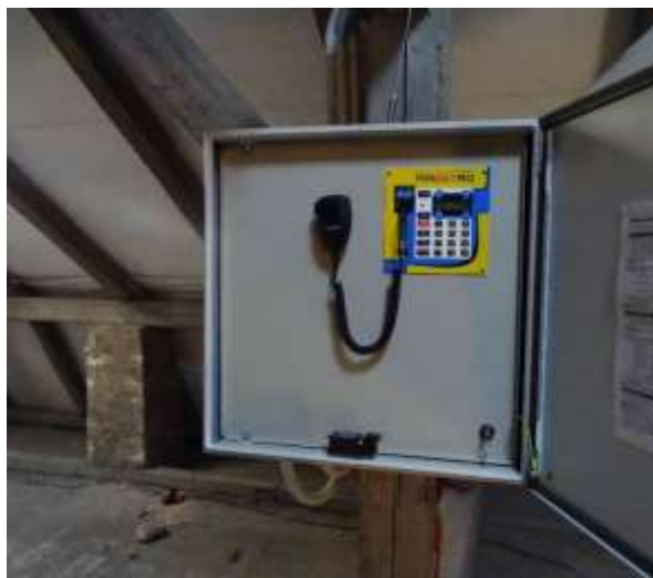
ES.1 – stávající siréna Maestro s ovládacím panelem a mikrofonom
