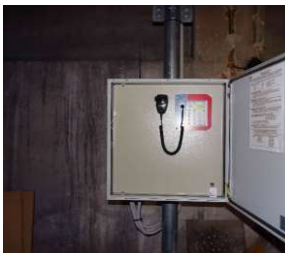
ES.15 – stávající siréna Maestro s ovládacím panelem a mikrofonom
