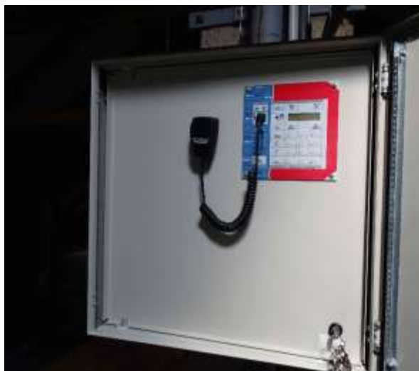
ES.19 – stávající siréna Maestro s ovládacím panelem a mikrofonom
