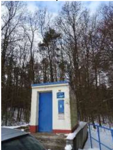
ES.10 – umístění stožáru s ozvučnicemi na zadní stěně vodárny
