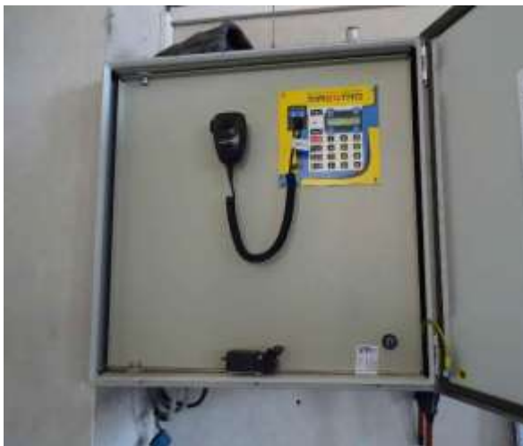
ES.5 – stávající siréna Maestro s ovládacím panelem a mikrofonem
