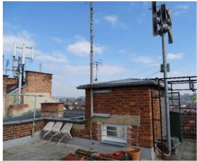
ES.14 – střecha ZŠ, umístění stožáru s ozvučnicemi
