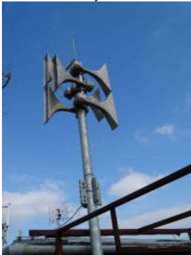
ES.14 – konfigurace ozvučnic 750d
