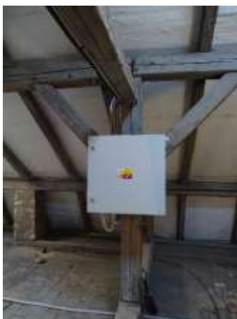
ES.1 – stávající řídicí skříň sirén na půdě ZŠ
