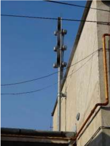
ES.5 – stožár a konfigurace ozvučnic 750s
