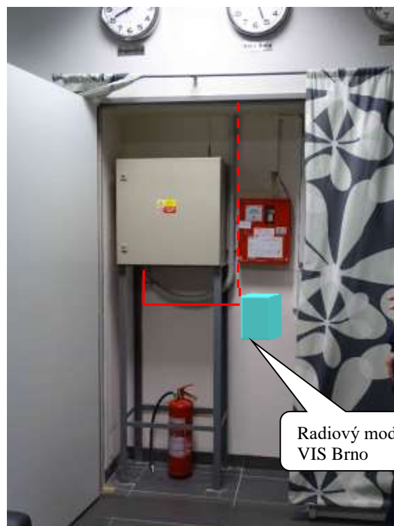
ESH.2 – umístění modulu VIS, anténa bude umístěna na střeše u sirény
