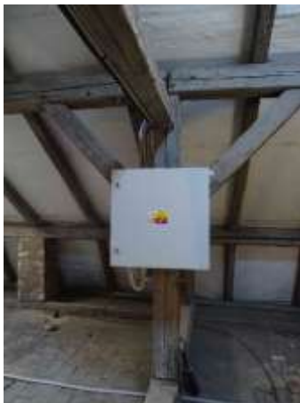
ES.9 – stávající řídicí skříň sirén na půdě
