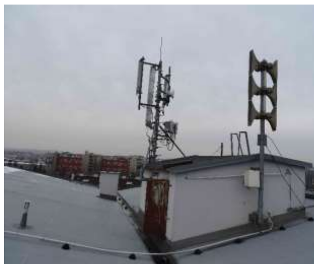
ES.26 – střecha ZŠ, umístění stožáru s ozvučnicemi
