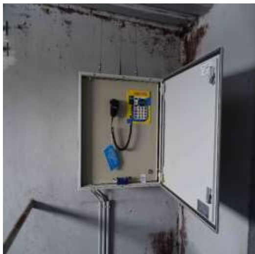
ES.20 – stávající siréna Maestro s ovládacím panelem a mikrofonom
