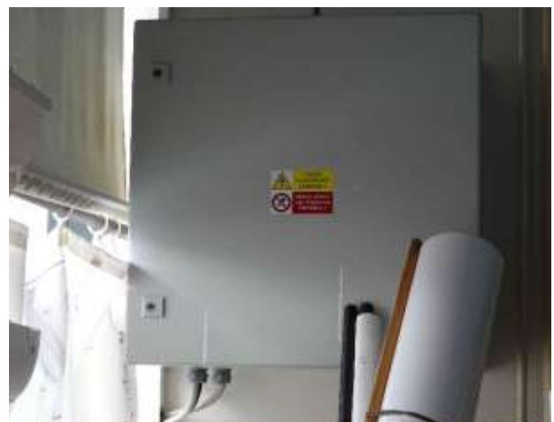
ES.22 – stávající řídicí skříň sirén v kabinetu ZŠ
