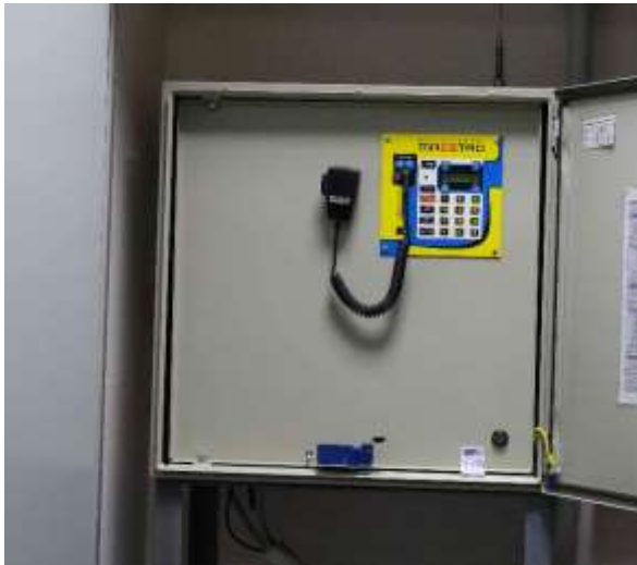
ESH.2 – stávající siréna Maestro s ovládacím panelem a mikrofonem
