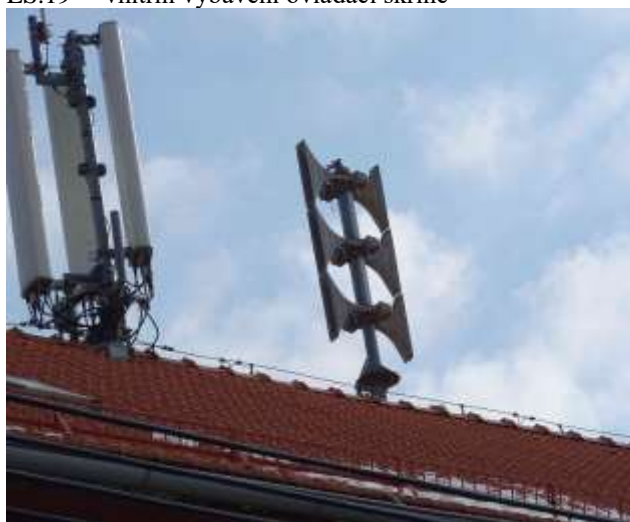
ES.19 – konfigurace ozvučnic 750s
