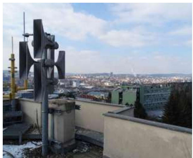
ES.17 – konfigurace ozvučnic 750d
