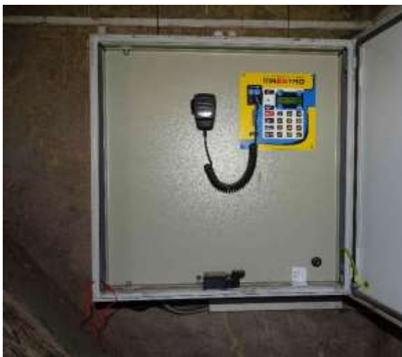
ESH.10 – stávající siréna Maestro s ovládacím panelem a mikrofonem
