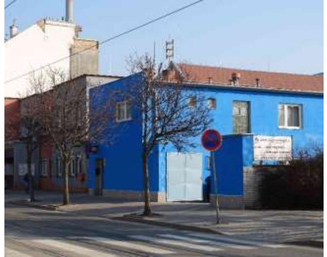
ES.3 – střecha ÚMČ, umístění stožáru s ozvučnicemi sirény
