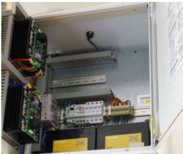
ES.4 – vnitřní vybavení ovládací skříň
