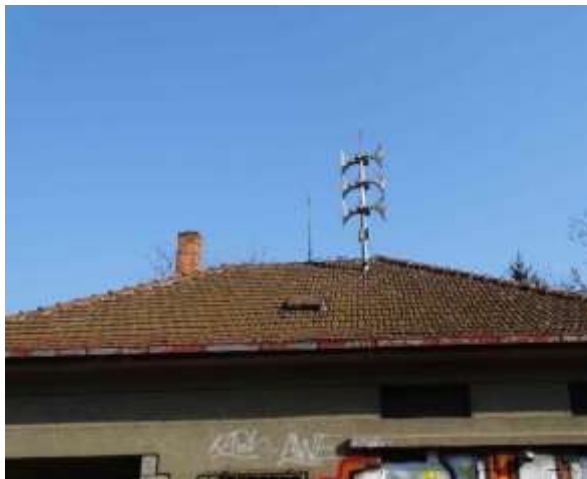
ES.2 – konfigurace ozvučnic 750s s
