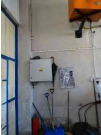
ES.5 – stávající řídicí skříň sirén na půdě ZŠ
