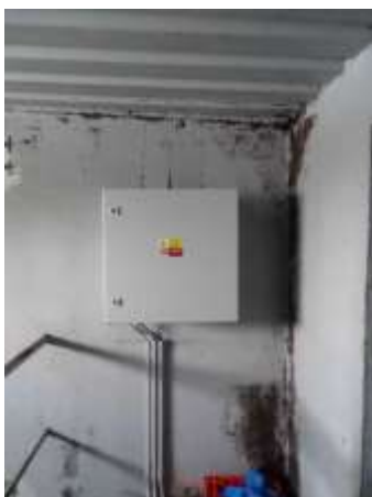
ES.20 – stávající řídicí skříň sirén na půdě ZŠ
