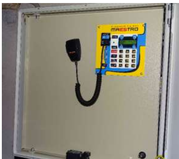
ESH.13 – stávající siréna Maestro s ovládacím panelem a mikrofonem
