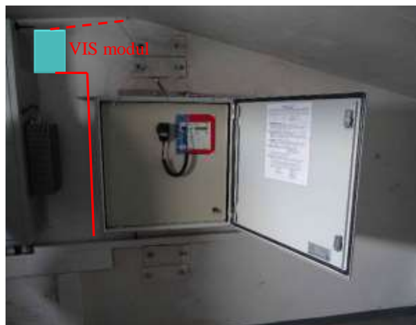
ES.26 – umístění modulu VIS, anténa bude umístěna na střeše na výložník stožáru sirény
