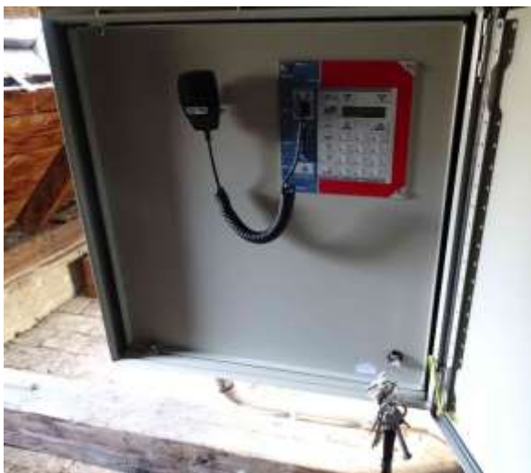
ES.18 – stávající siréna Maestro s ovládacím panelem a mikrofonem
