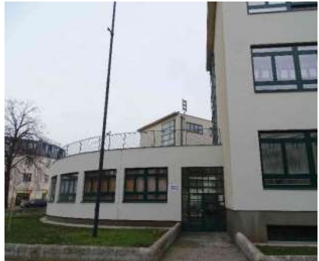
ES.22 – střecha ZŠ, umístění stožáru s ozvučnicemi
