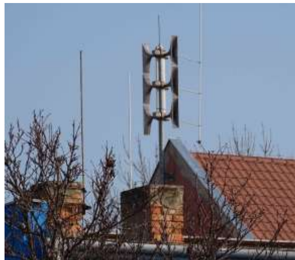
ES.3 – konfigurace ozvučnic 750s s oddáleným hromosvodem
