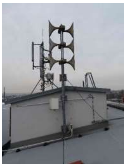
ES.26 – konfigurace ozvučnic 750s
