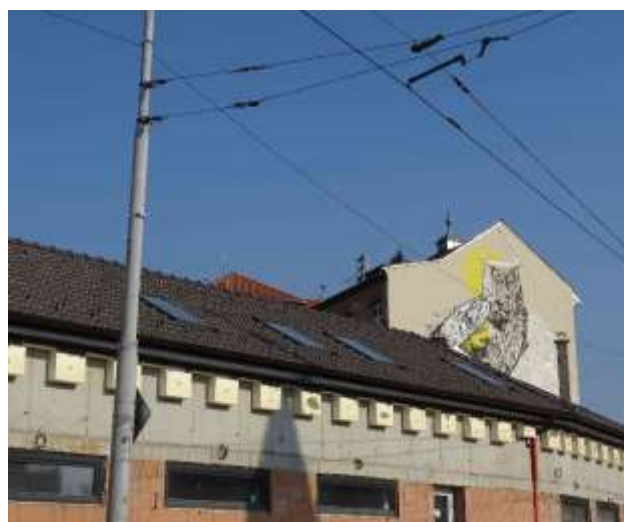
ES.1 – střecha ZŠ, umístění stožáru s ozvučnicemi
