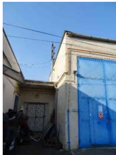
ES.5 – střecha ZŠ, umístění stožáru s ozvučnicemi
