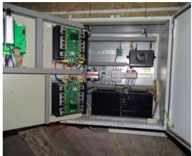
ESH.10 – vnitřní vybavení ovládací skříně
