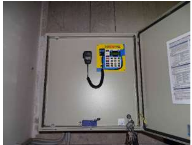
ES.17 – stávající siréna Maestro s ovládacím panelem a mikrofonem
