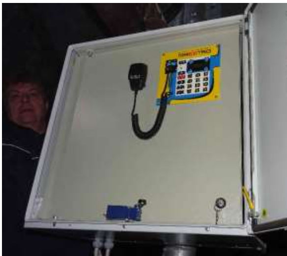
ESH.4 – stávající siréna Maestro s ovládacím panelem a mikrofonom
