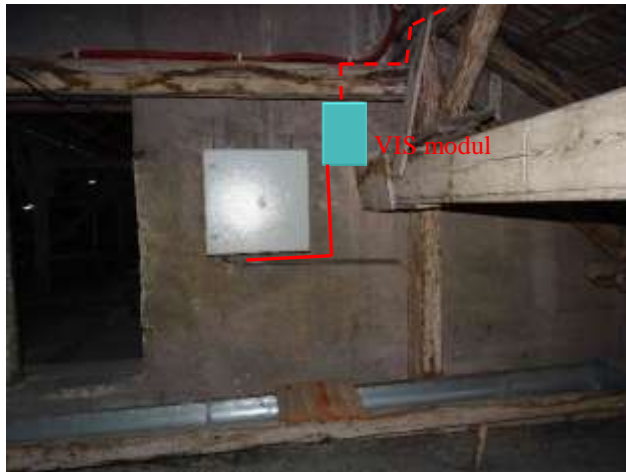
ES.16 – stávající řídicí skříň sirén na půdě ZŠ, umístění modulu VIS, anténa bude umístěna na střeše na výložník stožáru sirény
