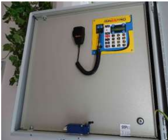
ES.3 – stávající siréna Maestro s ovládacím panelem a mikrofonom
