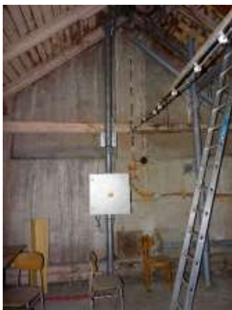
ES.15 – stávající řídicí skříň sirén na půdě ZŠ
