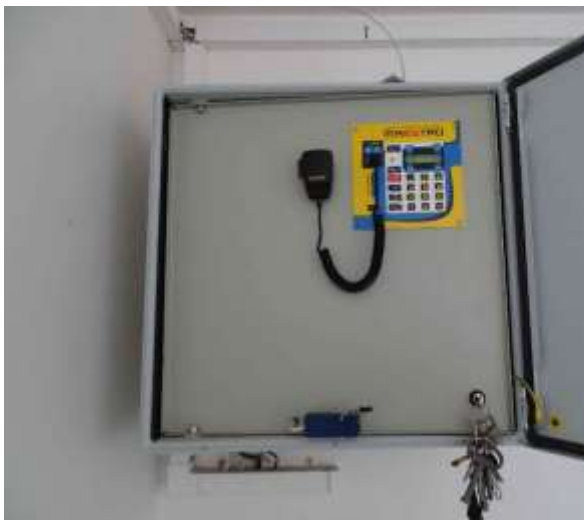
ES.14 – stávající siréna Maestro s ovládacím panelem a mikrofonom
