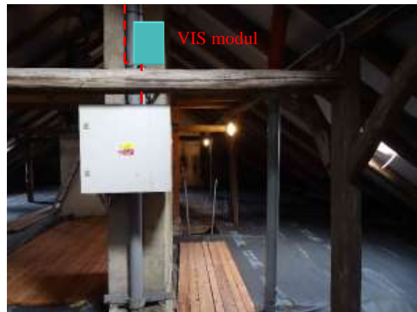
ES.19 – umístění modulu VIS, anténa bude umístěna na střeše na výložník stožáru sirény
