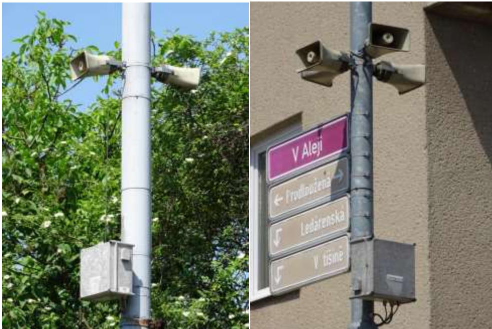
Obr. BH MIS Tuřany – stávající stav
