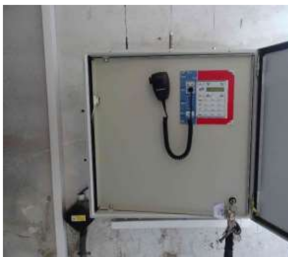
ES.11 – stávající siréna Maestro s ovládacím panelem a mikrofonem
