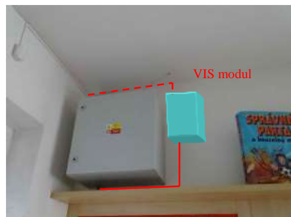
ES.4 – umístění modulu VIS, anténa bude umístěna na střeše na výložník stožáru sirény
