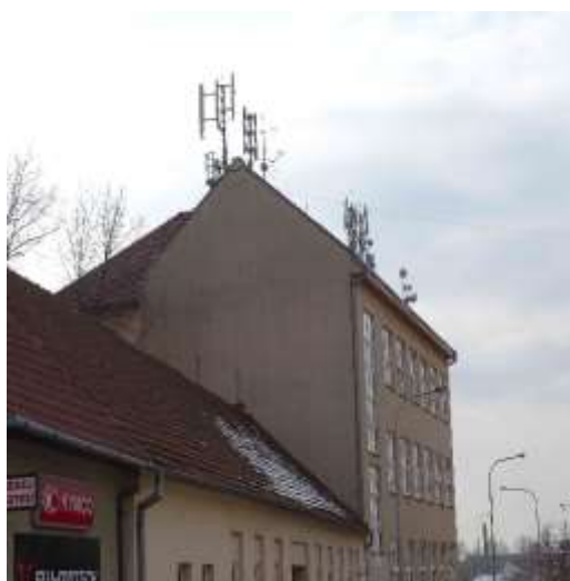
ES.15 – střecha ZŠ, umístění stožáru s ozvučnicemi
