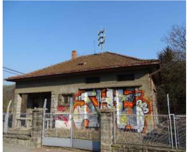
ES.2 – trafostanice ČD se stožárem sirény na střeše
