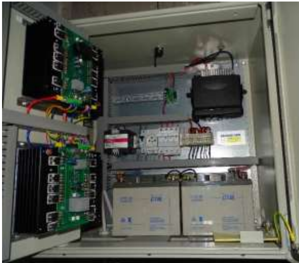
ES.17 – stávající siréna Maestro s ovládacím panelem a mikrofonem
