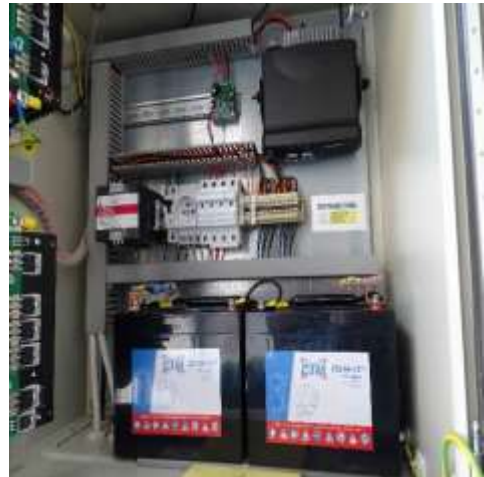
ES.12 – stávající siréna Maestro s ovládacím panelem a mikrofonem
