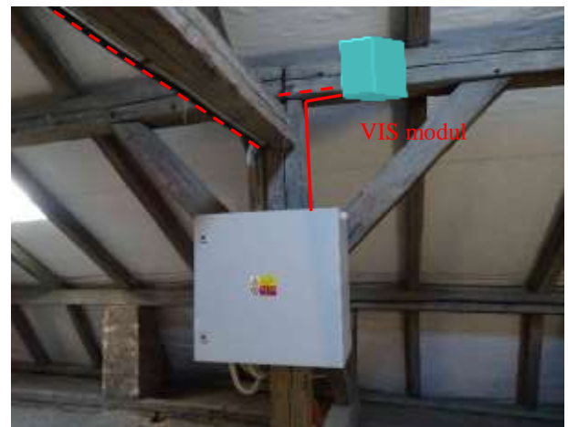
ES.1 – umístění modulu VIS, anténa bude umístěna na střeše na výložník stožáru sirény
