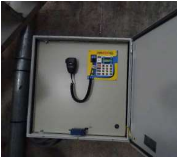
ES.13 – stávající siréna Maestro s ovládacím panelem a mikrofonem
