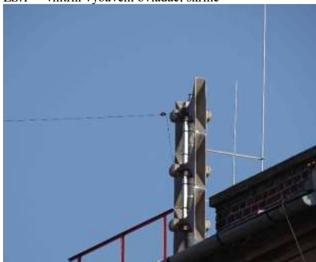
ES.1 – konfigurace ozvučnic 750s s oddáleným hromosvodem
