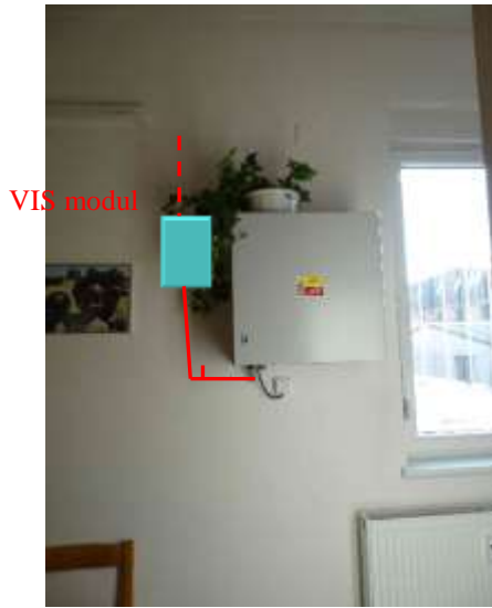
ES.3 – stávající řídicí skříň sirény, umístění modulu VIS, anténa bude umístěna na střeše na výložník stožáru sirény
