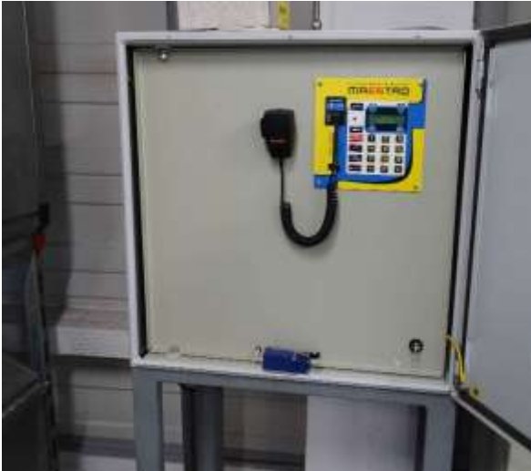
ESH.3 – stávající siréna Maestro s ovládacím panelem a mikrofonem
