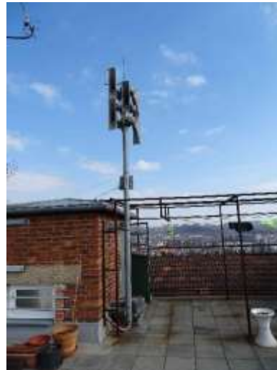
ES.14 – střecha ZŠ, umístění stožáru s ozvučnicemi
