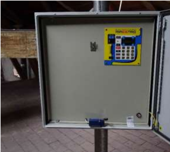
ESH.11 – stávající siréna Maestro s ovládacím panelem a mikrofonem
