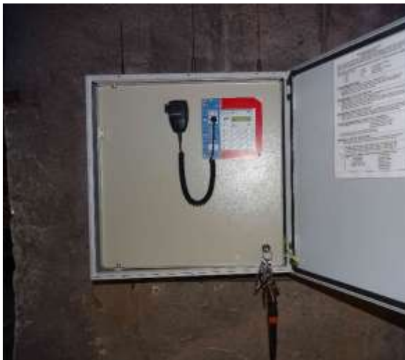
ES.16 – stávající siréna Maestro s ovládacím panelem a mikrofonem
