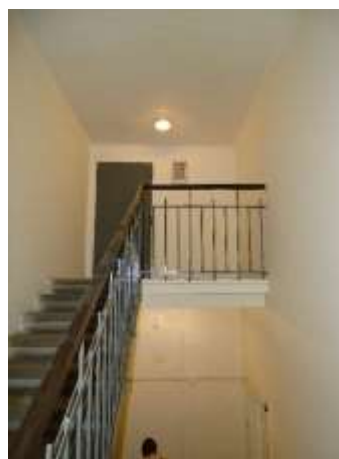
ES.24 – Nový stav, stoupačka z napájecího rozvaděče na půdu
