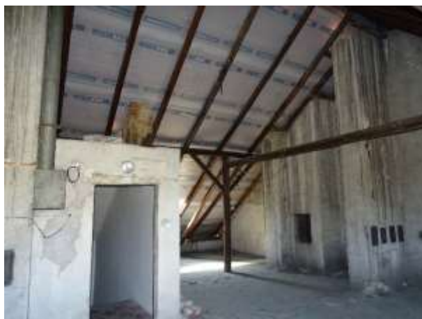
ES.24 – trasa napájecího kabelu
