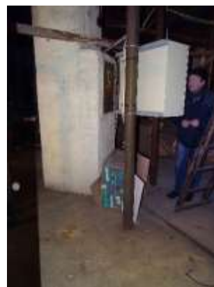
ES.24 – umístění rozvaděče na stožáru stávající sirény
